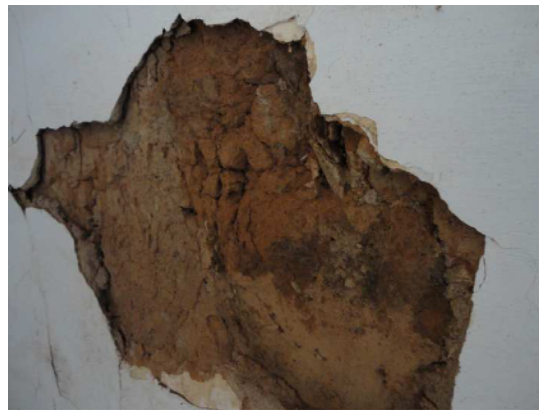
Figuras 07 e 08 – Perdas nas alvenarias e reboco. Fonte: Laudo de Estado de Conservação encaminhado ao IEPHA para o exercício 2012.
