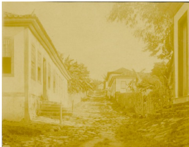
Figura 02 – Vista Parcial da Rua Direita de Estrela do Sul. Fonte: Arquivo Público Mineiro.
