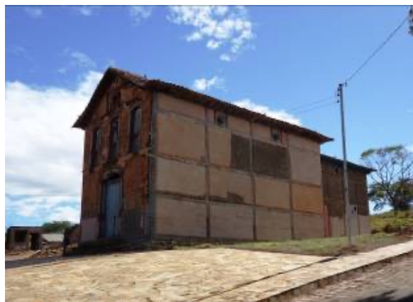
Figuras 13 e 14 – Imagens da edificação onde se verifica a remoção do reboco e aplicação de argamassa de cimento.
