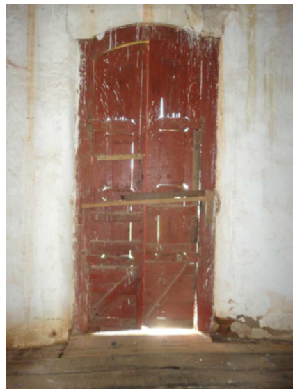
Figuras 09 e 10 – Danos e perdas nas esquadrias. Fonte: Laudo de Estado de Conservação encaminhado ao IEPHA para o exercício 2012.
