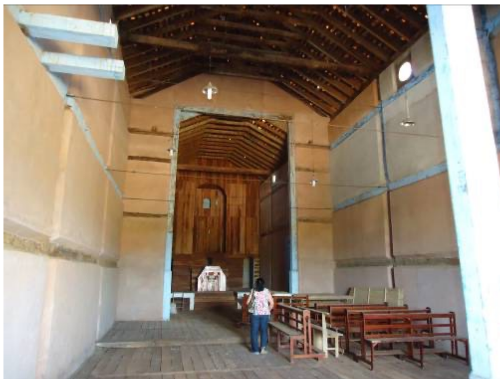
Figura 15 – Imagem interna com o reboco executado e novo piso instalado.
