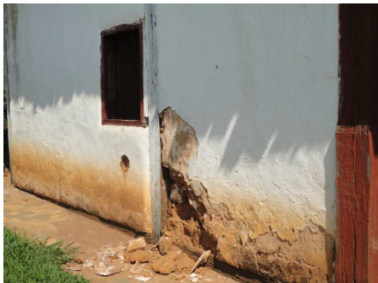
Figuras 07 e 08 – Perdas nas alvenarias e reboco. Fonte: Laudo de Estado de Conservação encaminhado ao IEPHA para o exercício 2012.
