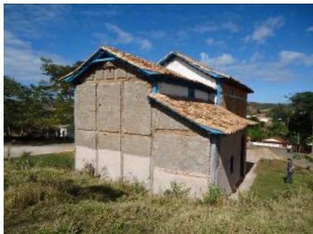
Figuras 13 e 14 – Imagens da edificação onde se verifica a remoção do reboco e aplicação de argamassa de cimento.
