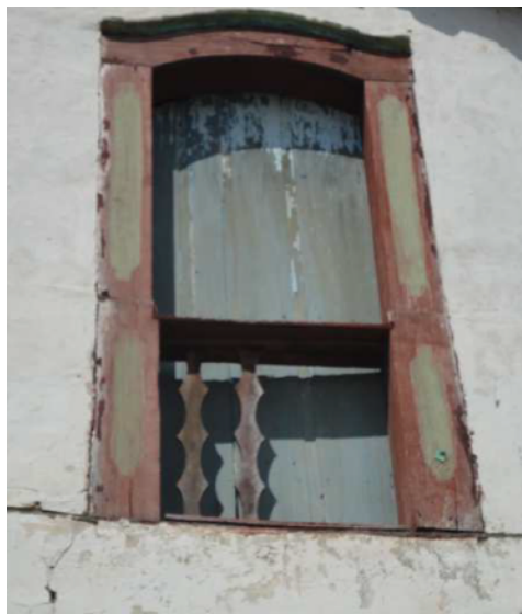
Figuras 09 e 10 – Danos e perdas nas esquadrias. Fonte: Laudo de Estado de Conservação encaminhado ao IEPHA para o exercício 2012.
