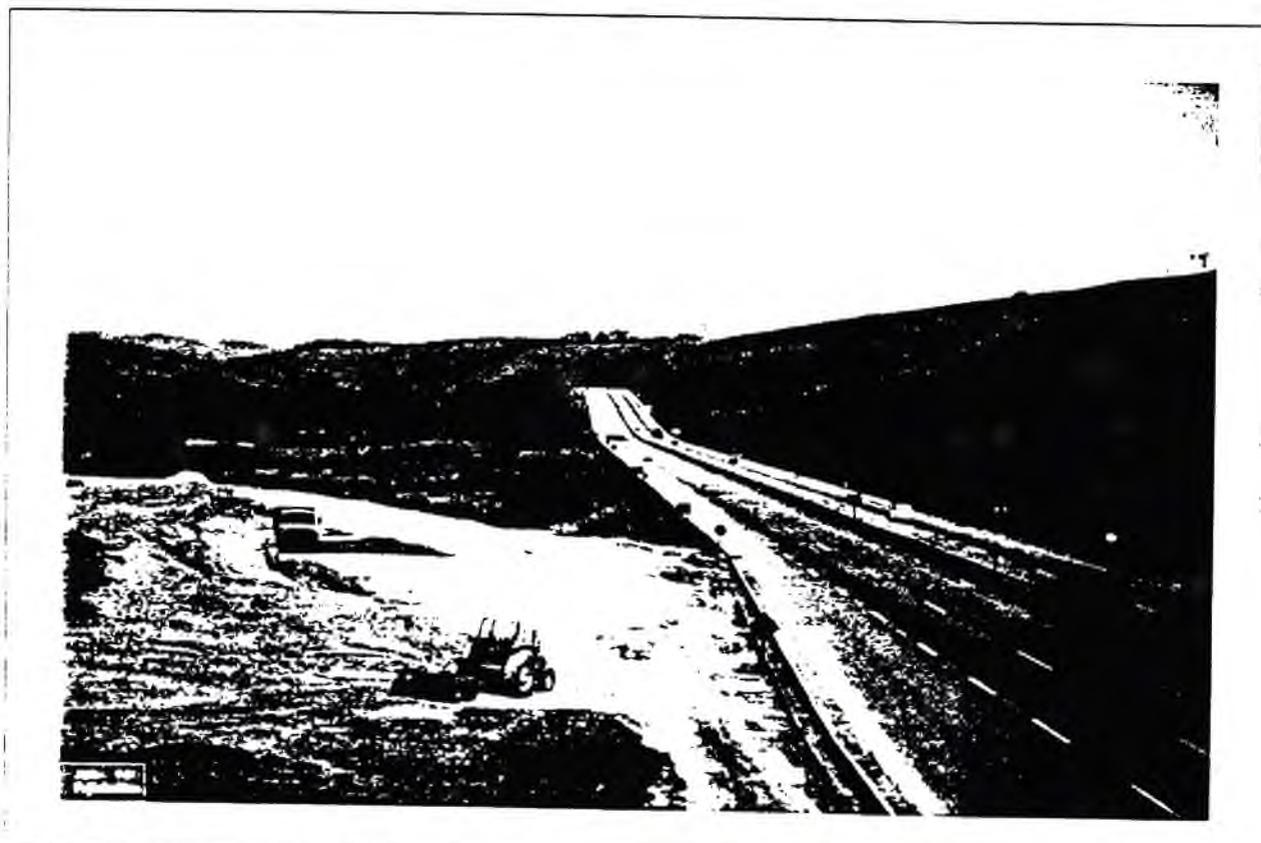
*Foto 04 - Obras de terraplanagem para construção da alça de acesso ao viaduto existente - notar ao fundo, Sede da Fazenda Novo Mundo*
