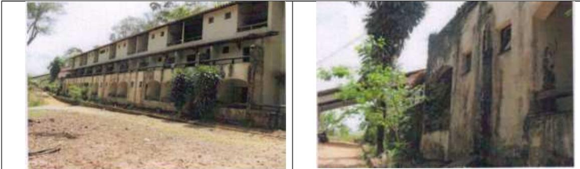
Figuras 5 e 6 – Fachada frontal do Hotel Poços de Fervedouro e detalhe mostrando manchas de umidade e plantas invasoras. Fonte: Ficha de inventário do Conjunto Paisagístico do Hotel Poços de Fervedouro.
