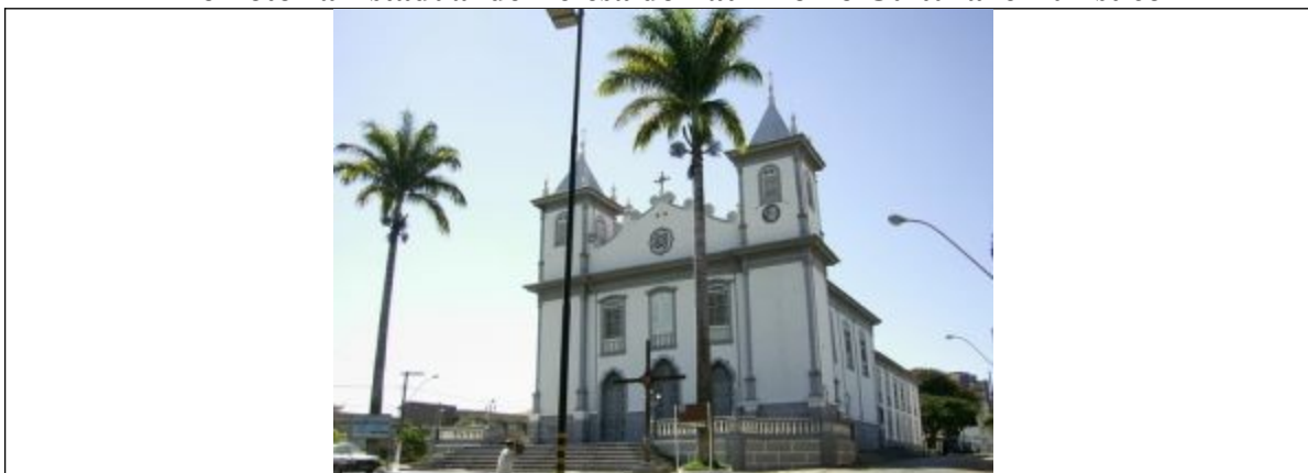
Figura 5 – Aspecto contemporâneo da Igreja Matriz de São Vicente Férrer
