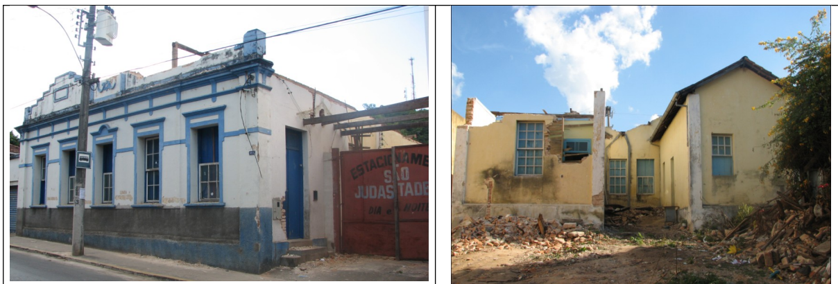
Figuras 04 e 05- Fachada principal e fundos do imóvel da Av. Marechal Deodoro, nº 404 em Formiga. Fotos da vistoria realizada em 31/05/2012 pela arquiteta Daniela Batista Lima.
