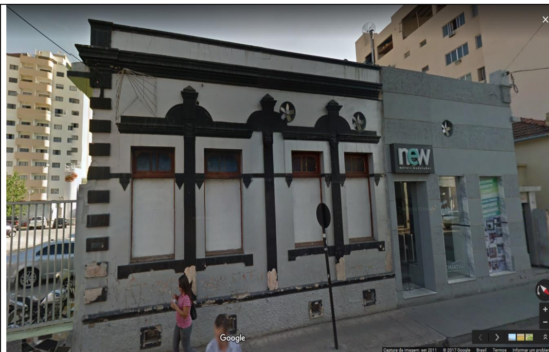
Figura 01 – Imagem do imóvel em setembro de 2011. Fonte: Google Street View.
