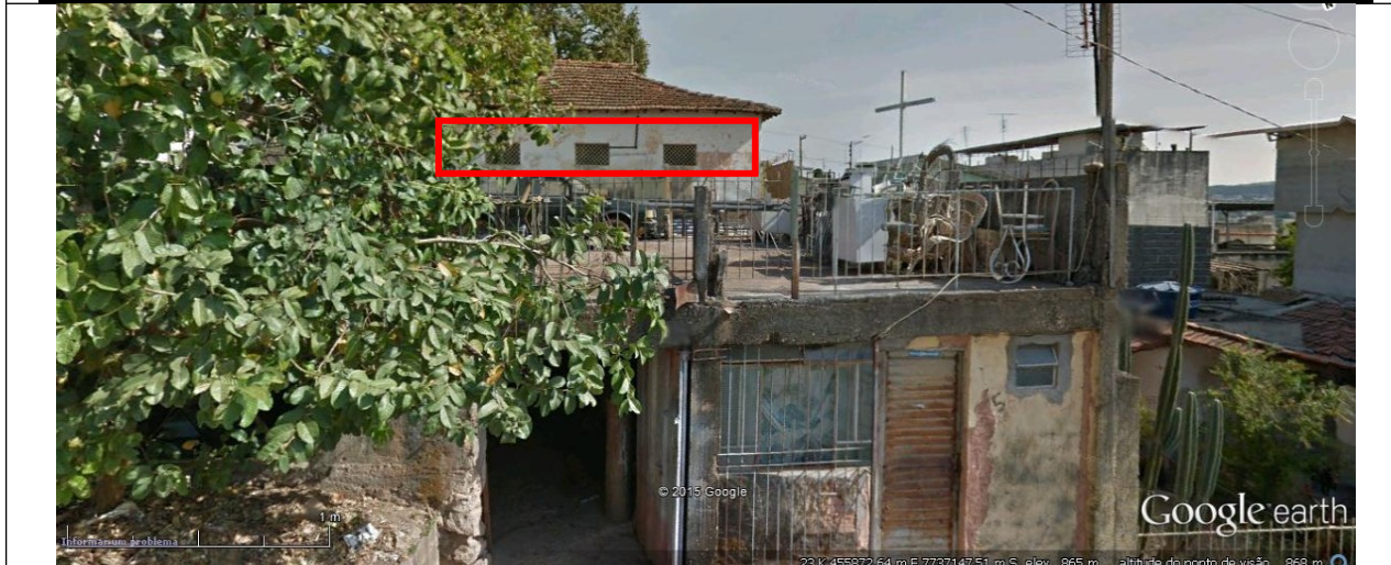
Figuras 06, 07, 08 e 09- Imagens do imóvel da antiga Caixa d'água do Rosário, datadas de setembro de 2011, coletadas software GoogleEarth . Acesso 07-05-2015. Foram assinaladas as janelas laterais da edificação.
