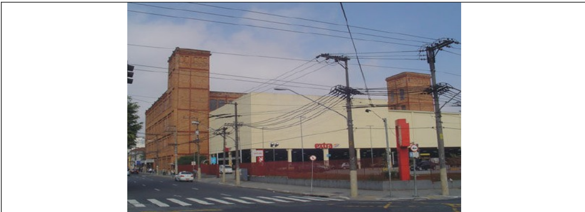
Figura 13- Parte das instalações do Cotonifício Crespi, transformado em hipermercado. Fonte:
