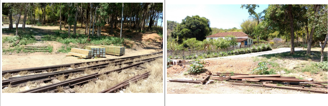
Figuras 12 e 13- Pátio da Estação Ferroviária de Formiga bastante impactado, com presença de materiais espalhados próximos aos trilhos. Fotos da visita ao município.
