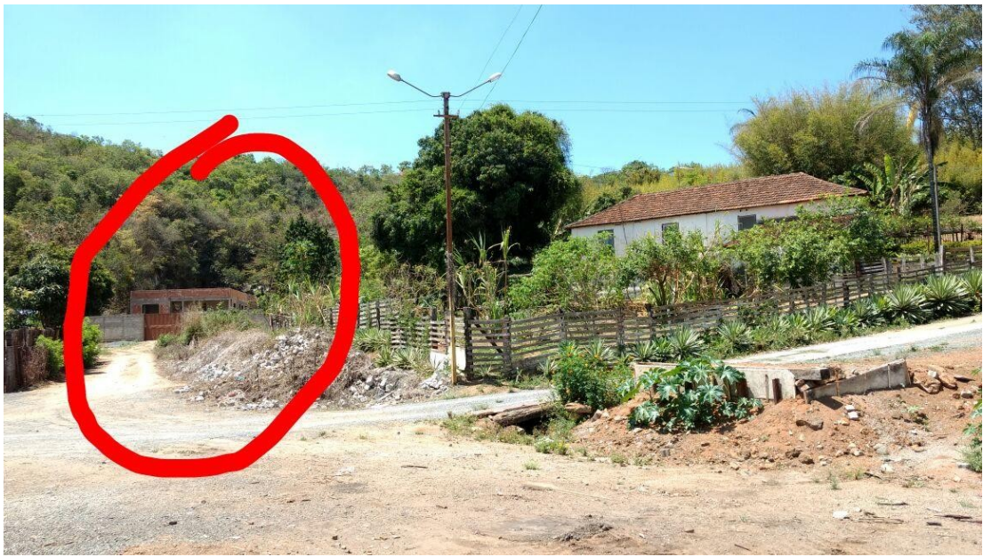
Figuras 14 e 15- Contexto de inserção da nova construção erguida no perímetro de entorno de tombamento da Casa do Engenheiro e da Estação Ferroviária em Formiga. Fotos da visita ao município.
