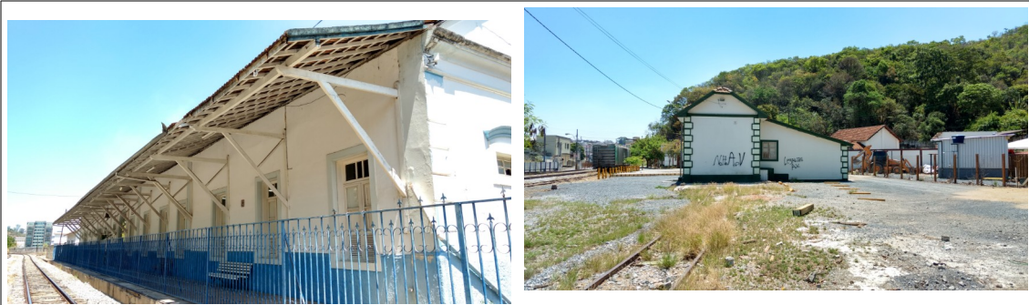
Figuras 8 e 9- Conjunto da Estação Ferroviária de Formiga. Na segunda imagem, destaca-se a Casa de Rádio, que está no perímetro de tombamento da Casa do Engenheiro.
