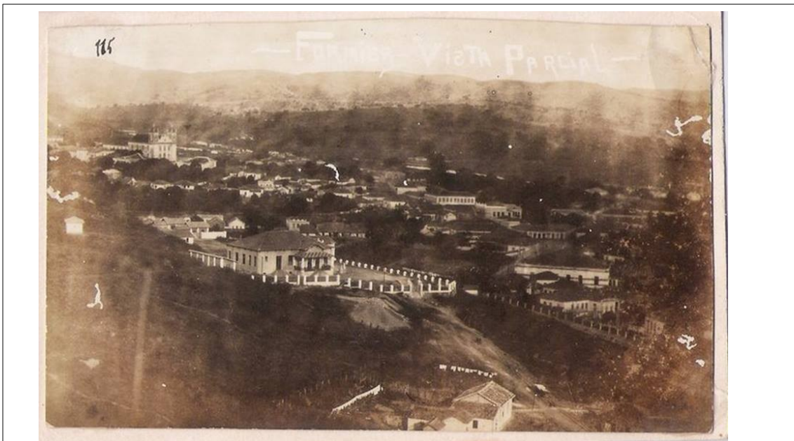
Figura 1 – Imagem antiga da Casa do Engenheiro em Formiga, 1926. Acervo particular: Luíza Rabelo Parreira.
