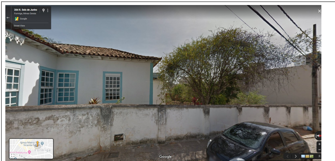
Figuras 1, 2 e 3- Imagens do imóvel situado na Praça São Vicente Férrer, nº 77, em Formiga, no ano de 2011. Fonte: Google Street View.
