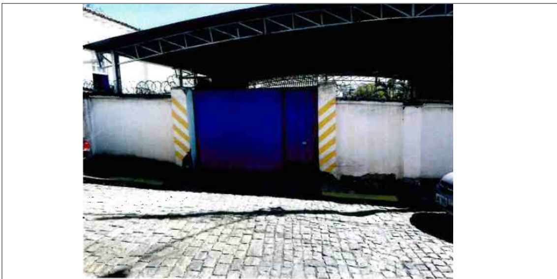
Figura 4- Fachada do estacionamento implantado no terreno do imóvel inventariado, situado na Praça São Vicente Férrer, em Formiga. Fonte: Laudo Técnico elaborado pela Secretaria Municipal de Obras e Trânsito, em 16 de agosto de 2018.
