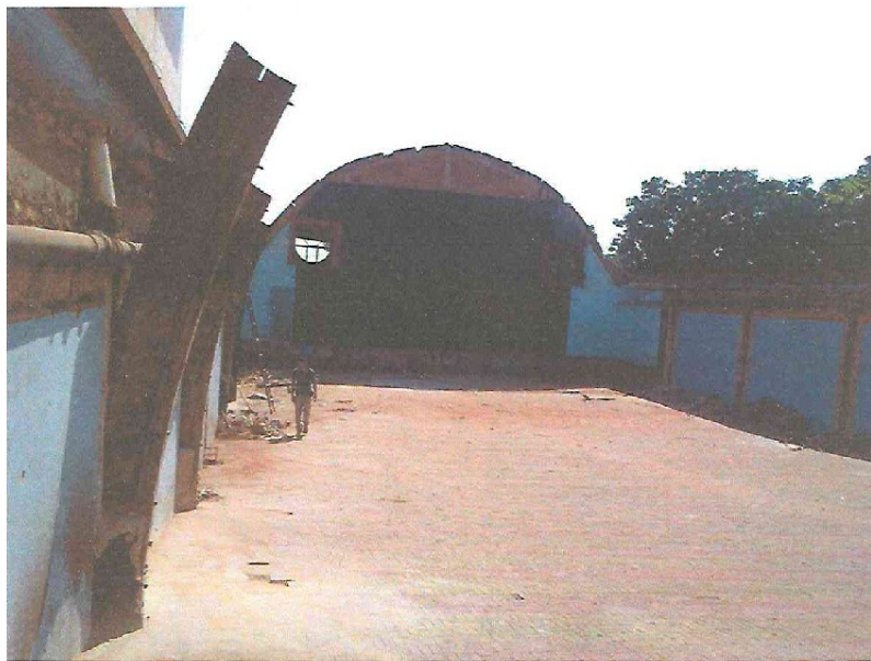
Figura 04 – Registro da demolição da cobertura em arco da sala de exposições e parte das alvenarias dos fundos.
