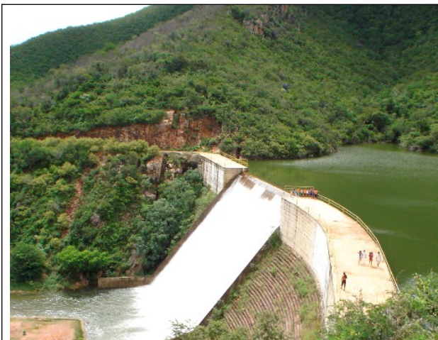
Figura 03- Barragem de Gameleiras, construída entre os anos de 1989 e 1991. Fonte: Documentação juntada aos autos.
