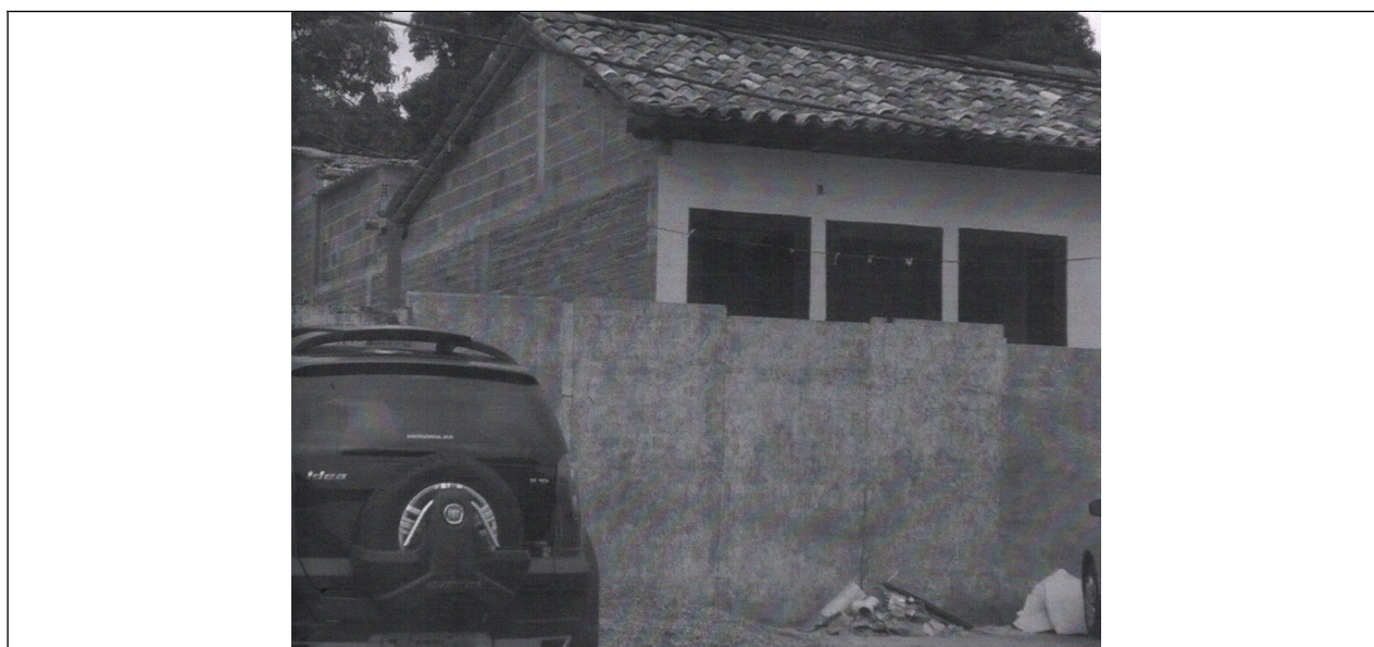
Figura 02 – Imagem da construção da edificação em concreto armado e vedação em tijolos cerâmicos.
