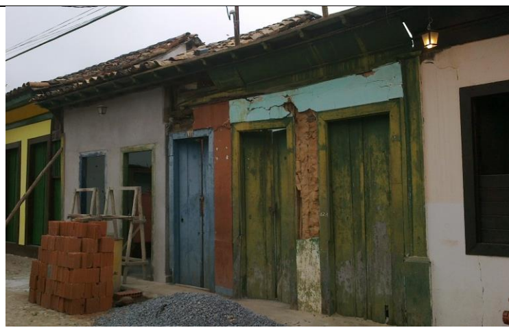
Figura 06 - Fachada do imóvel em setembro 2012, com o trecho da esquerda em fase final de reconstrução.
