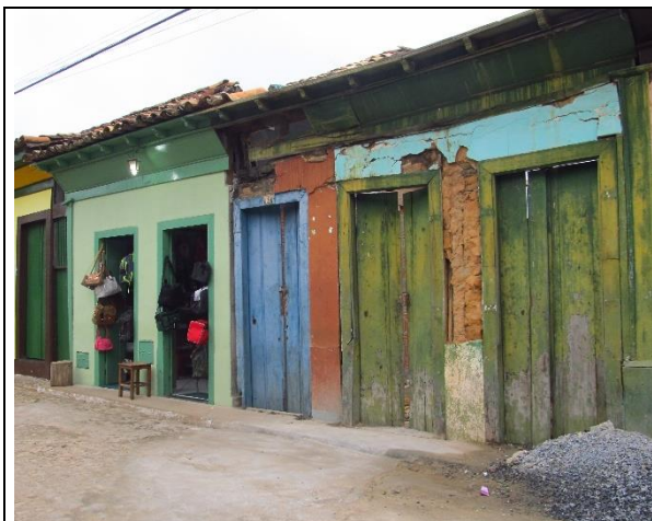
Figuras 07 e 08 - Fachada do imóvel em junho de 2013, quando da vistoria deste Setor Técnico em Grão Mogol. A reconstrução do trecho à esquerda já estava concluída e o trecho à direita encontrava-se destelhado e em avançado estado de degradação.
