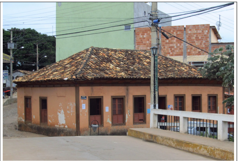
Figura 10 – Prédio tombado da Secretaria de Educação com o prédio em tela localizado nos fundos.
