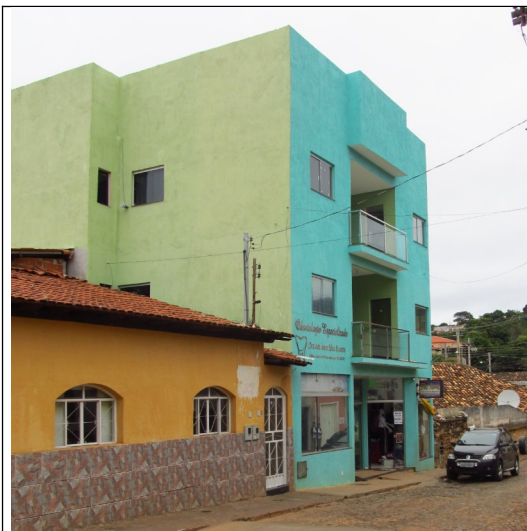
Figura 09 – Edificação localizada na rua Santa Rita nº 117.
