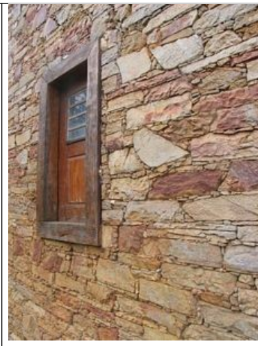
Figura 09 – detalhe sistema construtivo.
