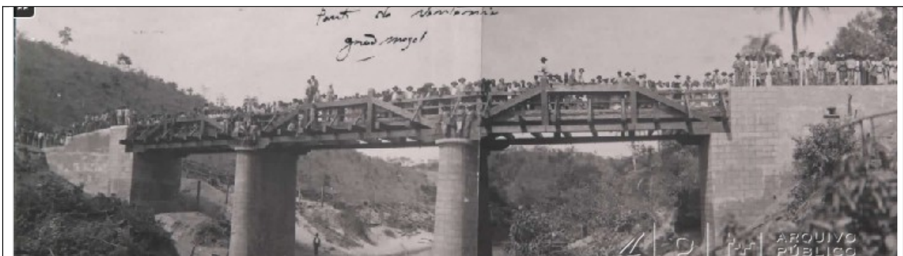
Figura 01 - Ponte sobre o Rio Ventania em Grão Mogol. Fonte: Arquivo Público Mineiro.
