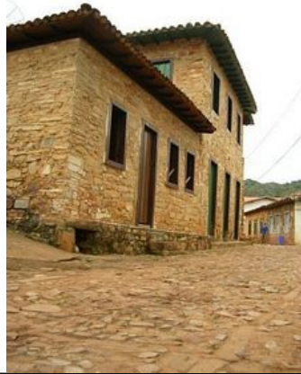
Figura 07 – Casario de pedras, sistema construtivo característico da região.
