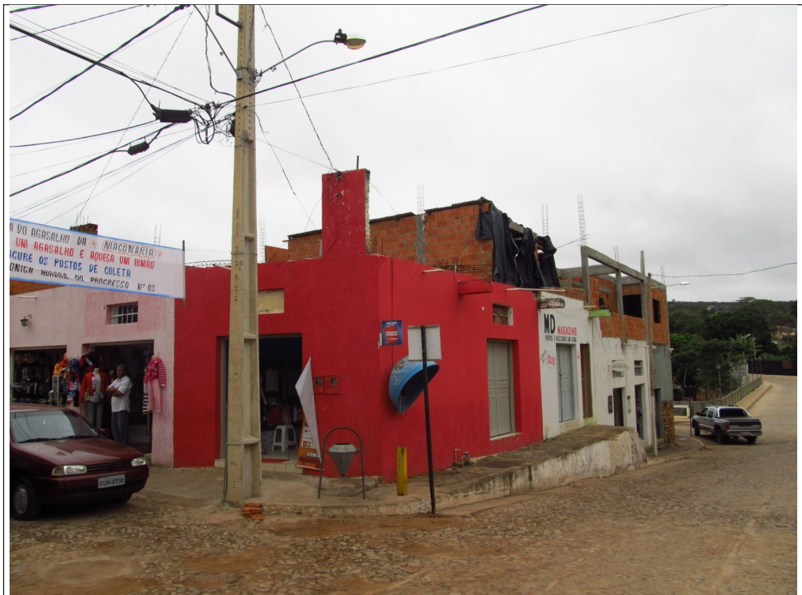
Figura 12 – A edificação antes da intervenção.
