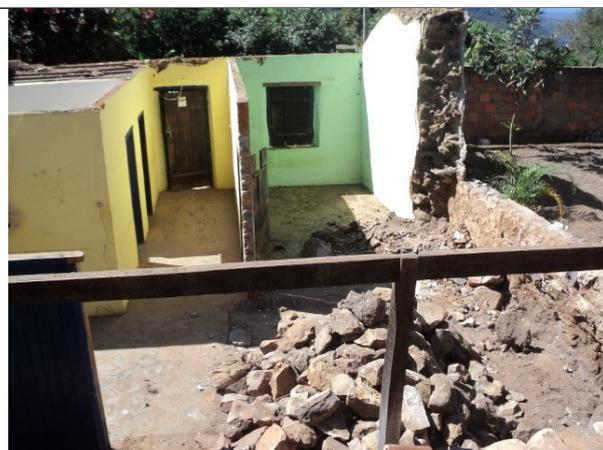
Figura 02 – Destelhamento e alvenarias arruinadas.
