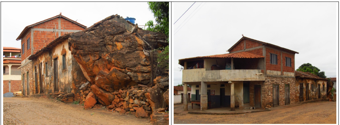
Figuras 09 e 10 – Edificação à rua Pedro Laborne 408 com a edificação em pedras de valor cultural junto à sua lateral direita.
