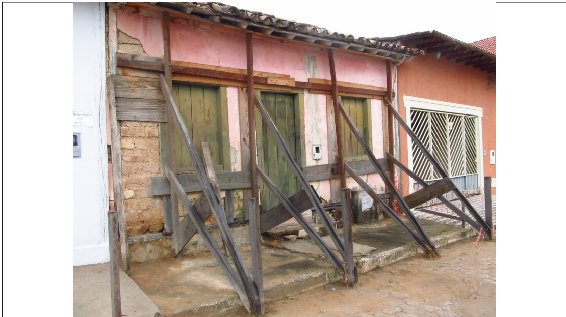
Figura 09 – Imagem de escoramento de fachadas. Fonte: Setor Técnico Promotoria Estadual de Defesa do patrimônio Cultural e Turístico de MG.
