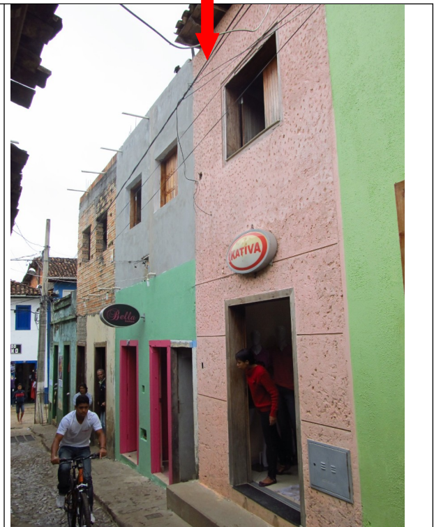
Figura 10 – Fachada da edificação.
