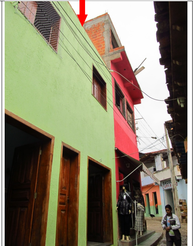
Figura 10 – Fachada da edificação.
