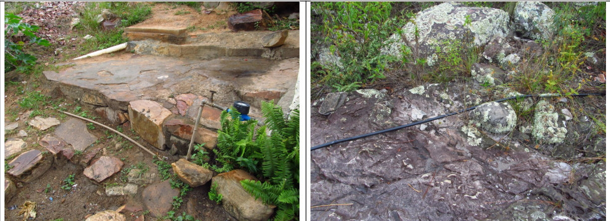
Figuras 21 e 22- Canos e mangueiras para captação de água atravessando a Trilha do Barão. Fotos da vistoria realizada pelo Setor Técnico desta Promotoria.
