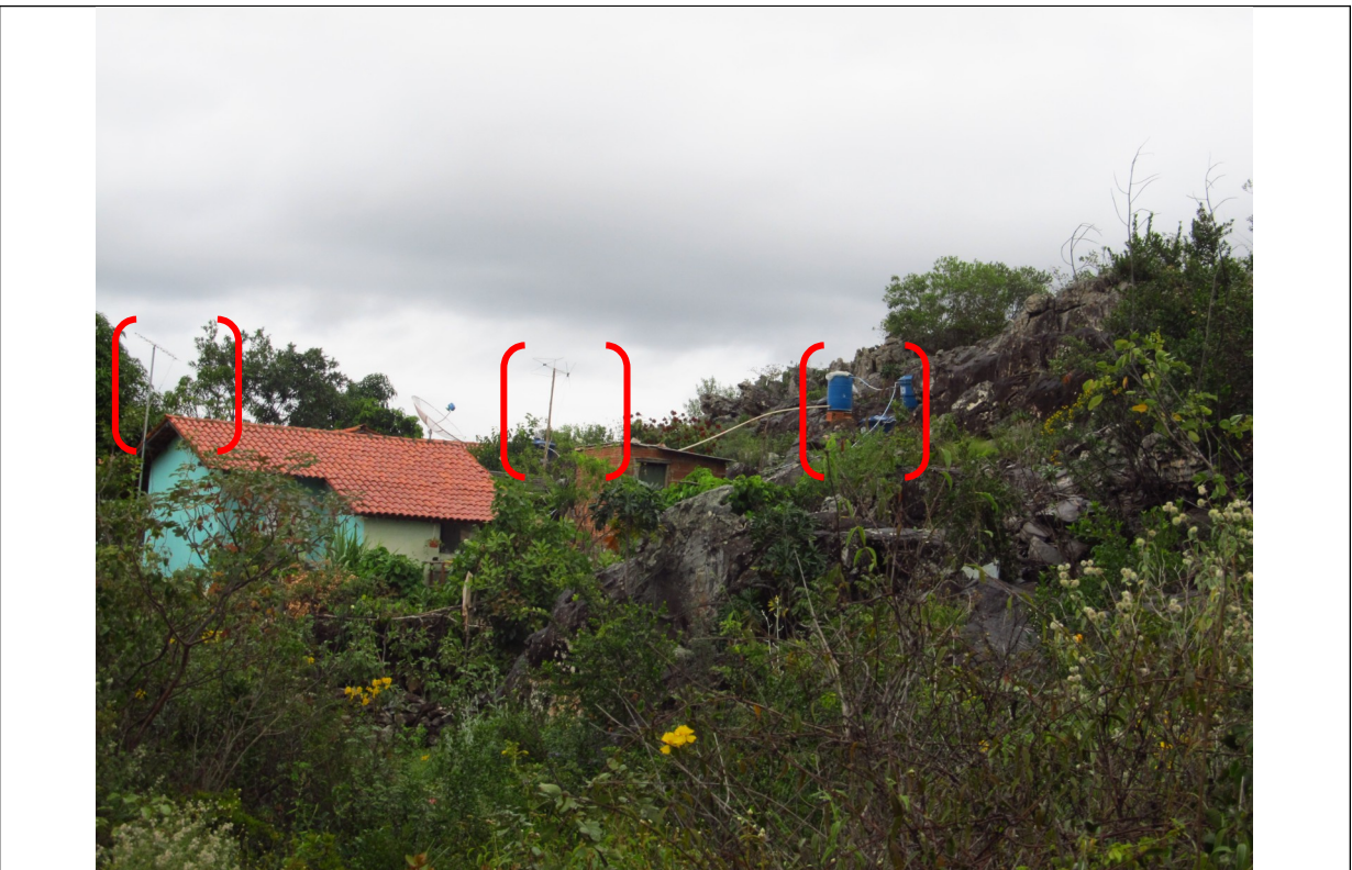
Figura 23- Presença de instalações elétricas e hidráulicas nas residências implantadas na Trilha do Barão. Foto da vistoria realizada pelo Setor Técnico desta Promotoria.
