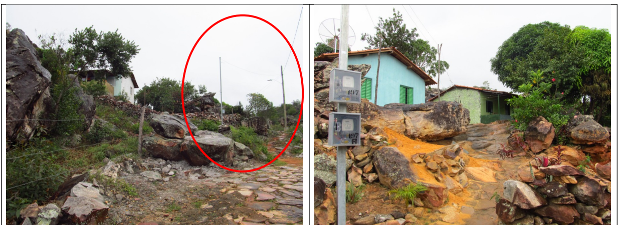
Figuras 19 e 20- Iluminação pública que atende as residências implantadas ao longo da Trilha do Barão. Fotos da vistoria realizada pelo Setor Técnico desta Promotoria.
