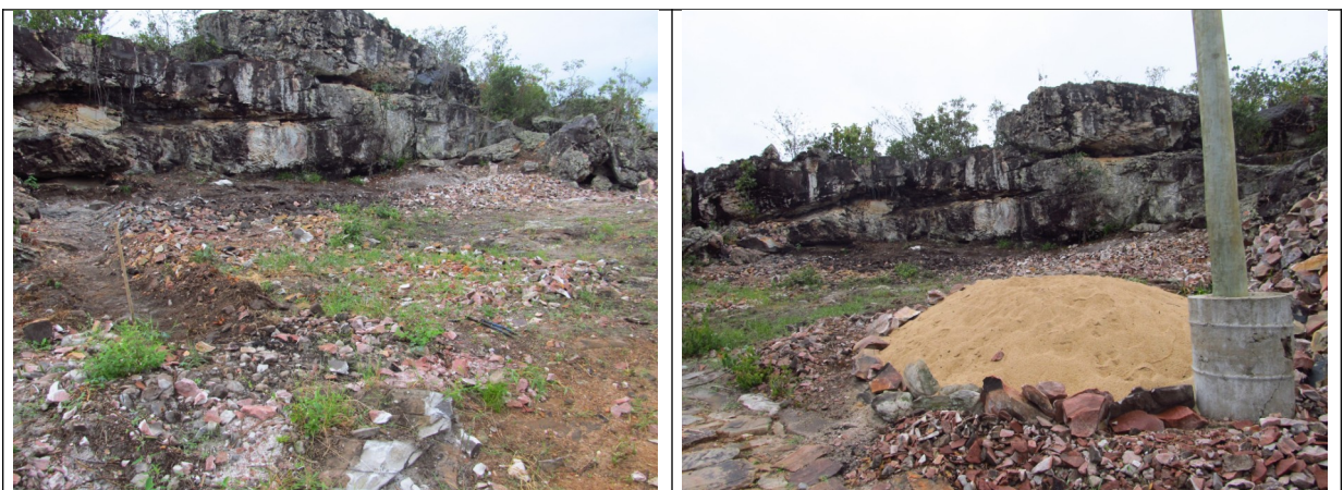
Figuras 26 e 27- Presença terreno aplainado e de materiais de construção na Trilha do Barão. Fotos da
