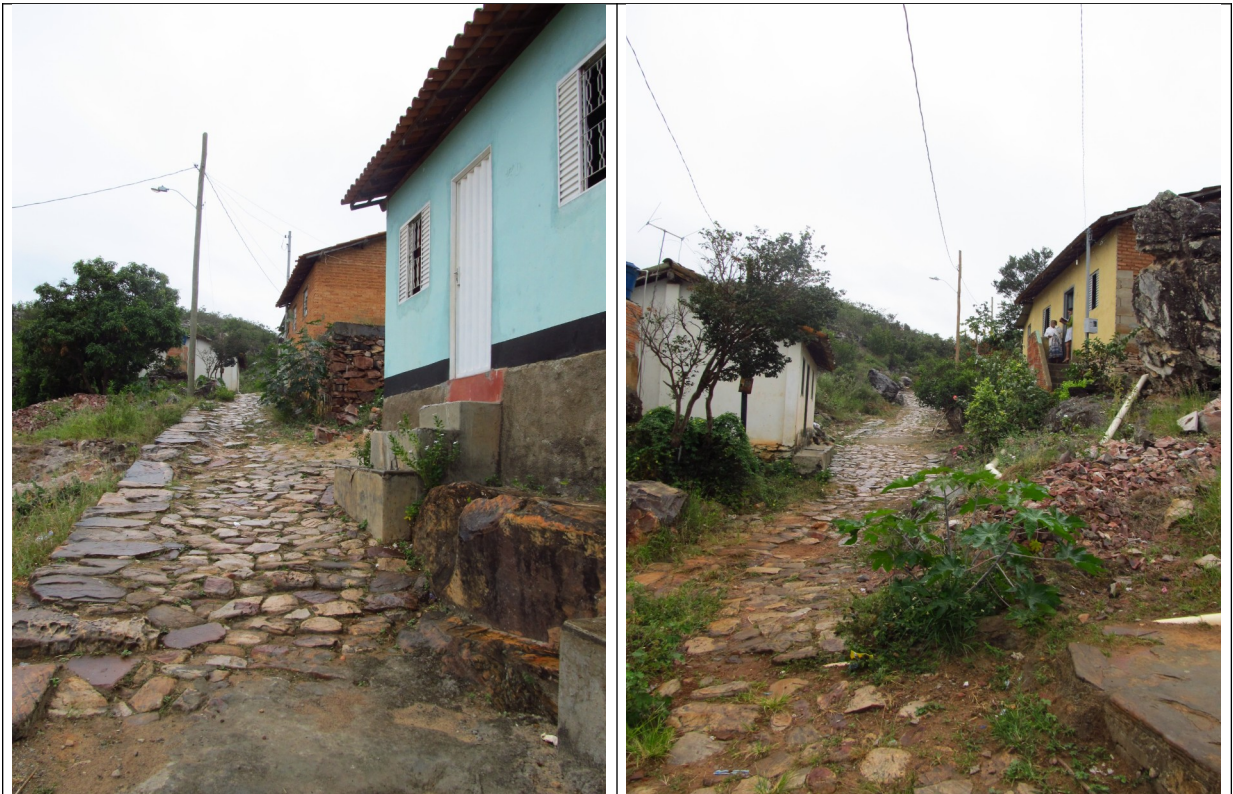
Figuras 17 e 18- Residências implantadas ao longo da Trilha do Barão, no núcleo urbano de Grão Mogol. Fotos da vistoria realizada pelo Setor Técnico desta Promotoria.
