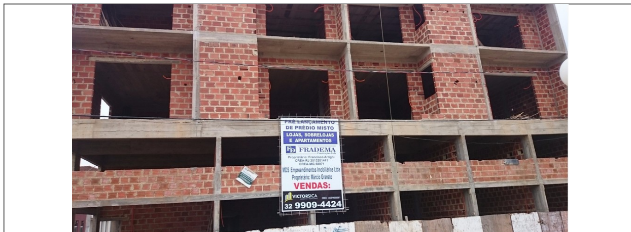
Figura 17 – Imagem do novo prédio em construção.
