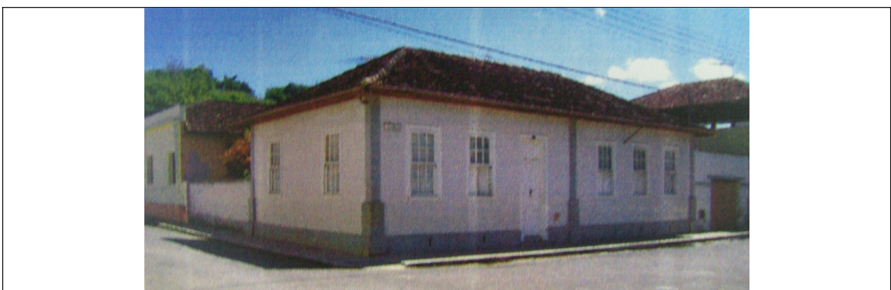
Figura 04 – Foto das fachadas principais da edificação, 2009 Fonte: Ficha de Inventário do imóvel.
