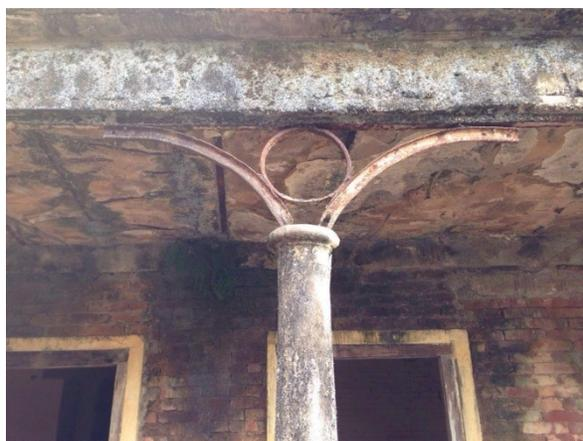
Figuras 11 e 12 – Comprometimento dos elementos integrantes da edificação, especialmente devido à umidade.
