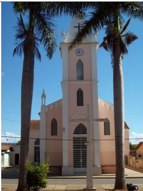
Figura 7 – Igreja Matriz de São Sebastião. Bem inventariado pelo município em 2006.
