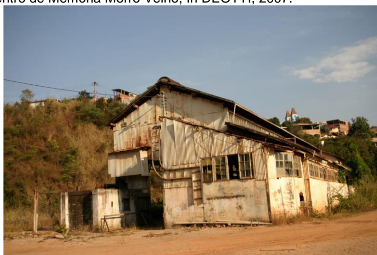
Figura 49 – Prédio da Elétrica. Data provável da construção: década de 1920 Fonte: Centro de Memória Morro Velho, In DEOTTI, 2007.
