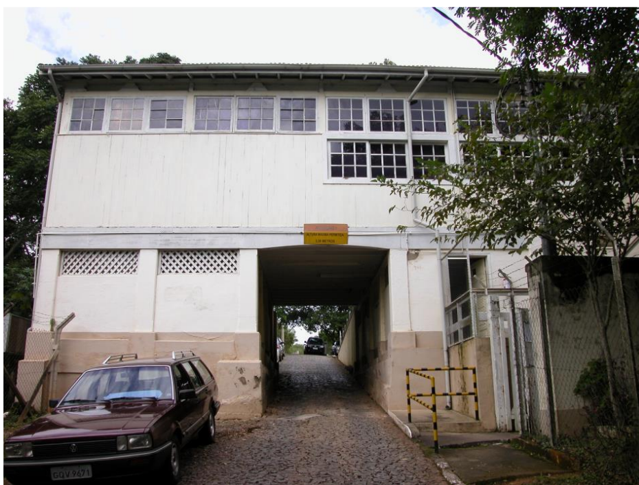
Figura 88 – Parte posterior do prédio do Escritório Velho, mostrando a segmentação da planta para passagem de carros Fonte: Centro de Memória Morro Velho, In DEOTTI, 2007.
