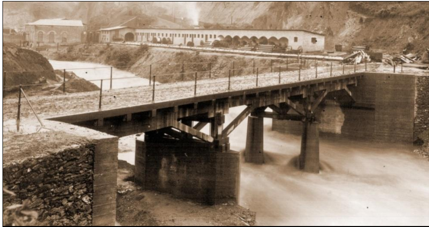
Figura 144 – Fotografia histórica de uma ponte sobre o córrego Cardoso, próximo à Fábrica de Cadinhos
