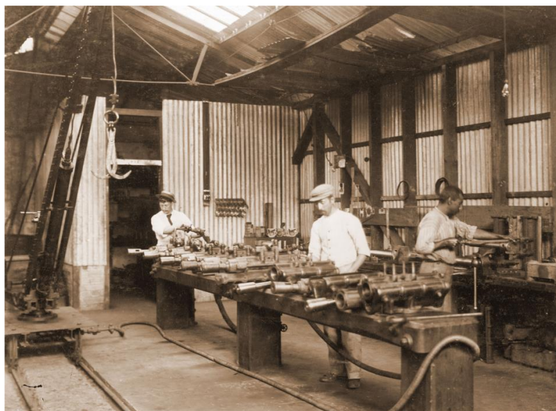
Figura 53 – Prédio da Área Industrial: detalhe da vedação das paredes com chapas de amianto ou zinco ondulado. Data provável: década de 1910
