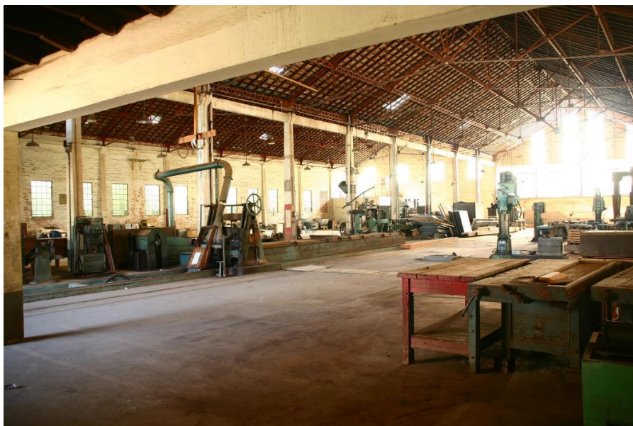
Figura 54 – Detalhe da viga e das estruturas em concreto pré-moldado aparente no prédio da Carpintaria. Data: 2006 Fonte: Centro de Memória Morro Velho, In DEOTTI, 2007.
