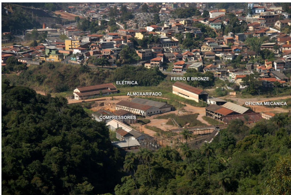
Figura 24 – Foto panorâmica parcial da Área Industrial, destacando-se os prédios das Oficinas Mecânicas, Casa de Força, Fundição de Ferro e Bronze, Almojarifado e da Elétrica. Data provável: 2005
