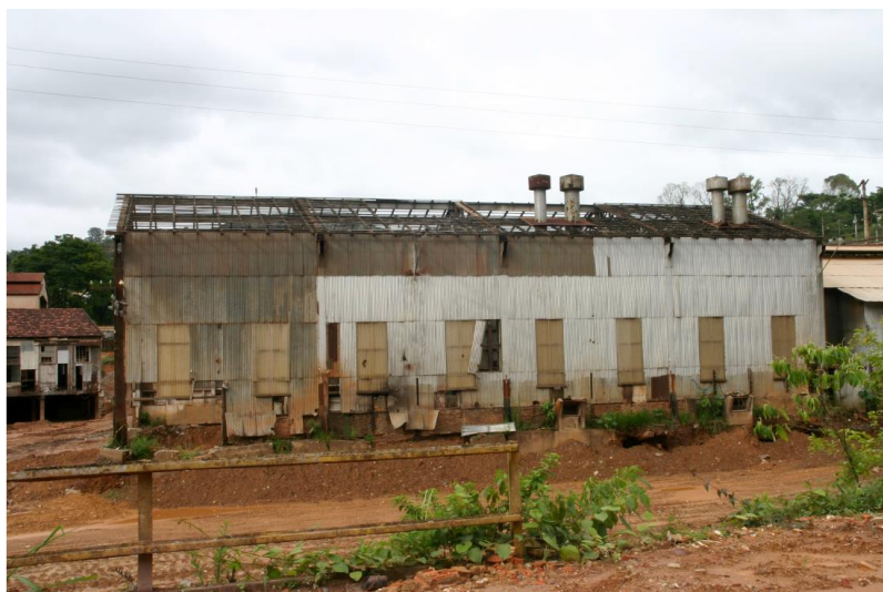
Figura 47 – Prédio dos Compressores / Subestação. Data provável de construção: de 1892 a 1920 Fonte: Centro de Memória Morro Velho, In DEOTTI, 2007.
