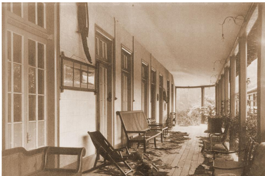
Figura 27 – Foto datada do início da década de 1900, mostrando a varanda frontal Fonte: Centro de Memória Morro Velho, In DEOTTI 2007.
