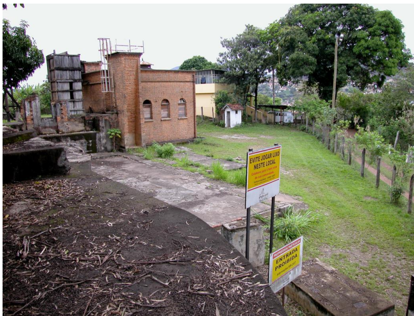
Figura 66 – Vista da área do Shaft do Mingú, construção de 1892 a 1920 Fonte: Centro de Memória Morro Velho, In DEOTTI, 2007.
