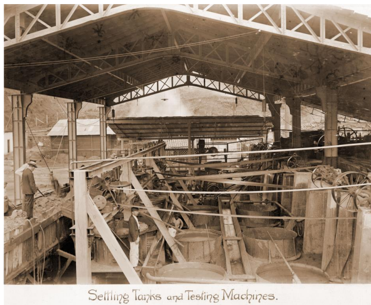
Figura 52 – Detalhes da estrutura metálica nos pilares de sustentação e no engradamento do telhado, grandes vãos dos galpões e cobertura em telhas de amianto dos prédios da Área Industrial. Data provável: década de 1910
