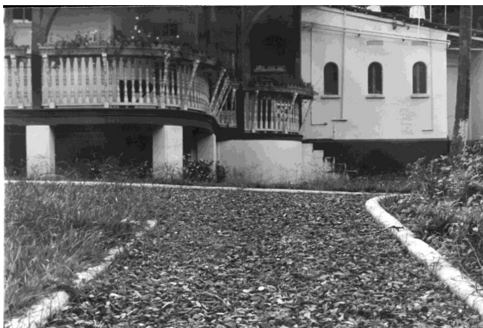
Figura 30 – Parte posterior da edificação, mostrando a varanda posterior em curva Fonte: Centro de Memória Morro Velho, In DEOTTI, 2007.
