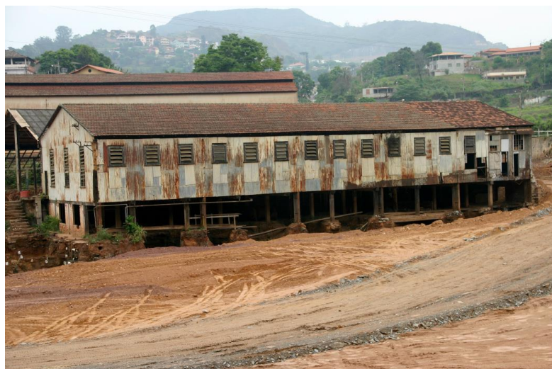
Figura 48 – Prédio do Almoarifado, onde funcionava a Fábrica de Cadinhos, nas proximidades do Antigo Engenho. Data provável de construção: de 1892 a 1920 Fonte: Centro de Memória Morro Velho, In DEOTTI, 2007.
