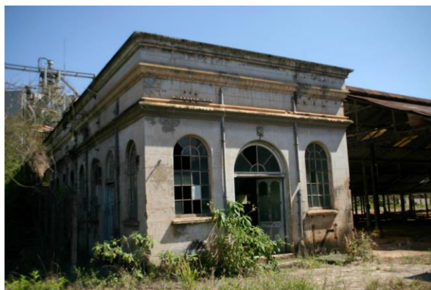
Figura 43 – Casa de Força. Data provável da construção: primeiro quartel do século XX, estilo eclético Fonte: Centro de Memória Morro Velho, In DEOTTI, 2007.
