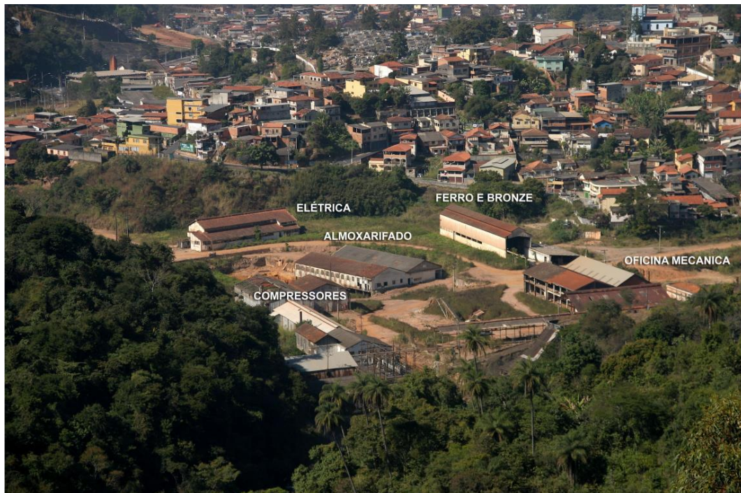
Figura 71 – Foto panorâmica parcial da Área Industrial, destacando-se os prédios das Oficinas Mecânicas, Casa de Força, Fundição de Ferro e Bronze, Almojarifado e da Elétrica. Data provável: 2005
