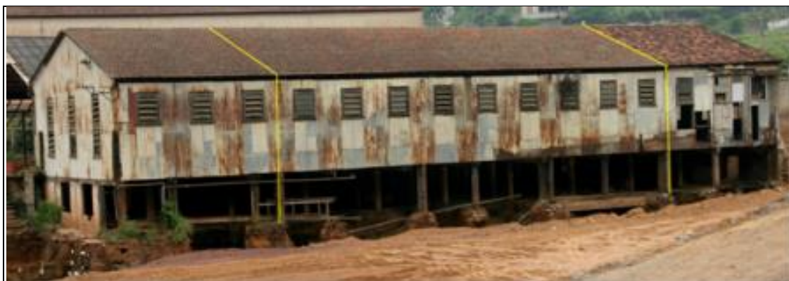
Figura 150 – Fábrica de Cadinhos depois da remoção das estruturas e sedimentos circundantes, realizada como parte dos trabalhos de desativação, em 2005
