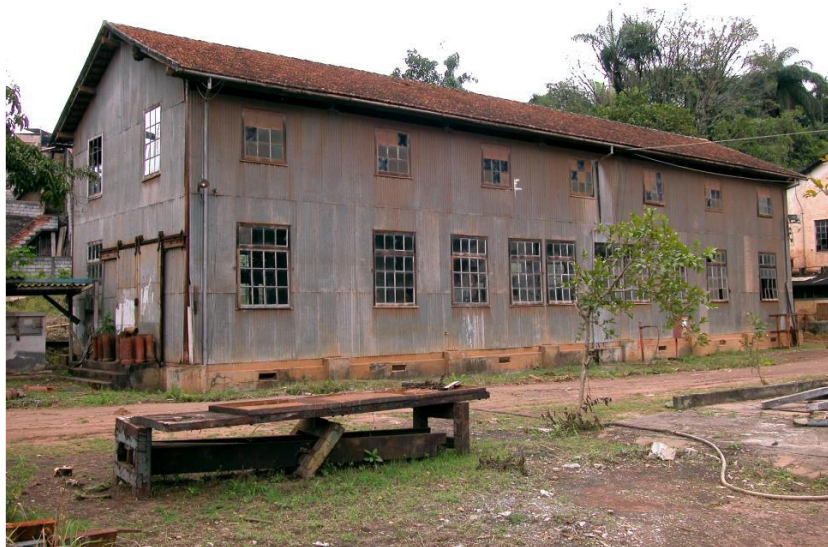
Figura 64 – Casa de Moldes. Data da construção: 1935 Fonte: Centro de Memória Morro Velho, In DEOTTI, 2007.
