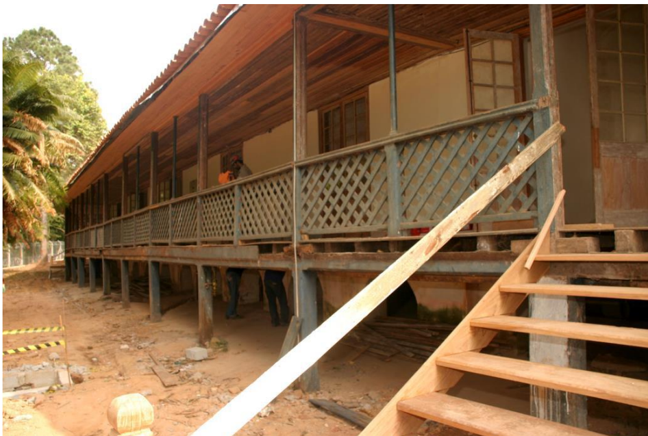
Figura 85 – Hospital de Morro Velho durante a reforma do ano de 2005: fachada frontal Fonte: Centro de Memória Morro Velho, In DEOTTI, 2007.
