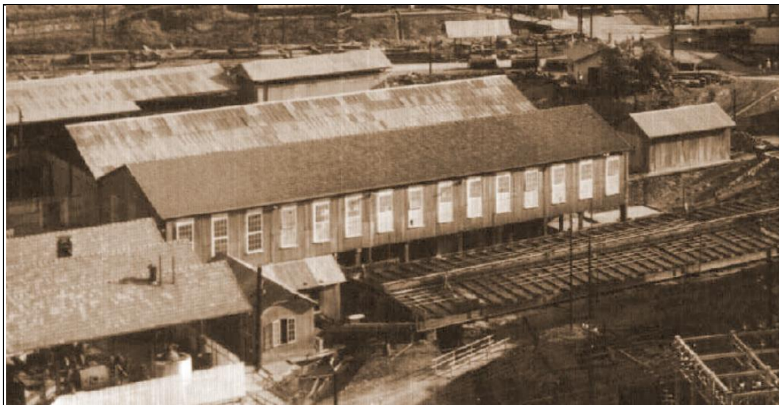
Figura 146 – Fotografia mais antiga identificada até o momento, da Fábrica de Cadinhos já com o primeiro andar instalado
