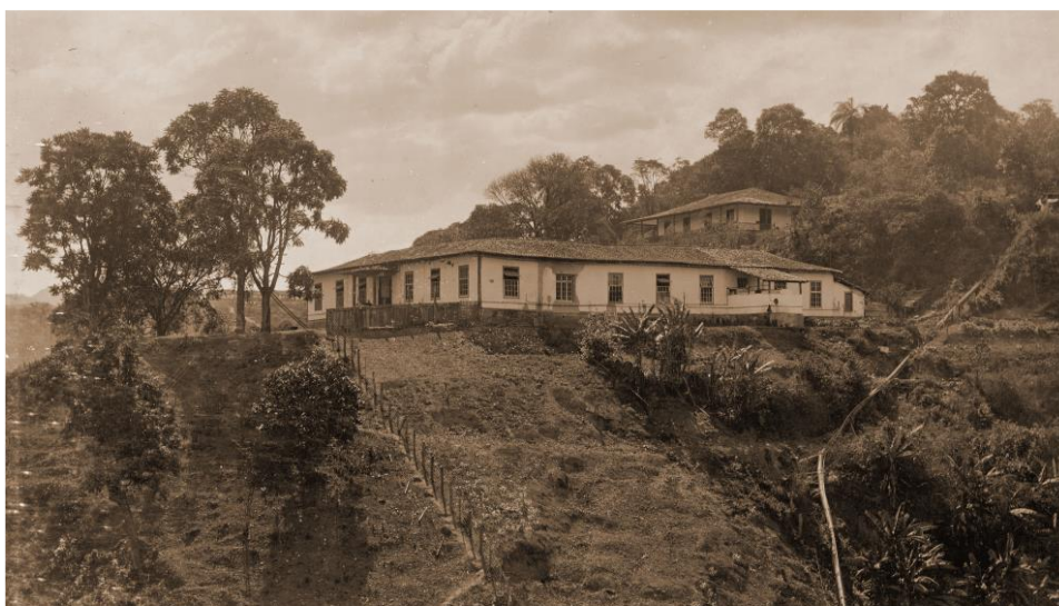
Figura 74 – Hospital Antigo de Morro Velho. Data de construção: 1848. Ao fundo, à direita, a residência dos médicos
