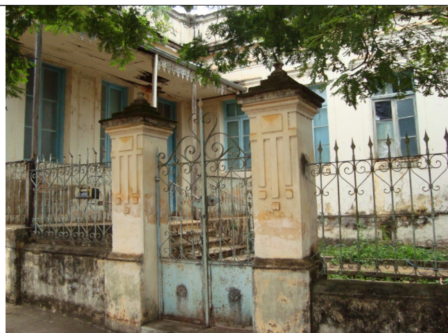
Figura 04 – Gradis e fechamento do terreno.
