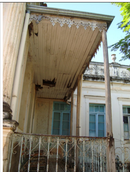
Figuras 06 e 07 – Forro danificado e elementos de ferro oxidados.
