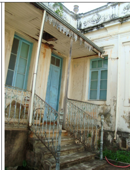
Figuras 06 e 07 – Forro danificado e elementos de ferro oxidados.
