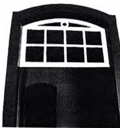
DETALHE DA BANDEIRA FIXA DE PORTA INTERNA DO BEM
