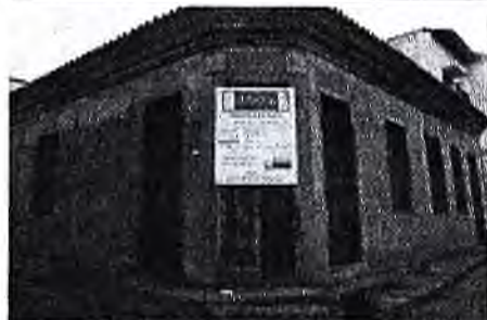
FOTOS DURANTE A REFORMA FINALIZADA EM 2007
