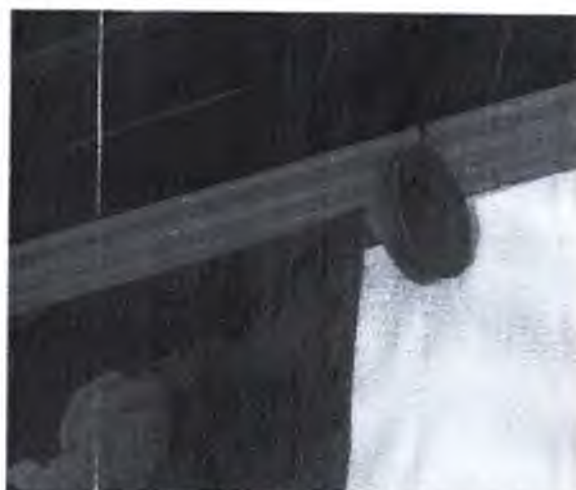
FOTO 04: Detalhe do carretel de madeira utilizado como sistema de fixação do painel.
