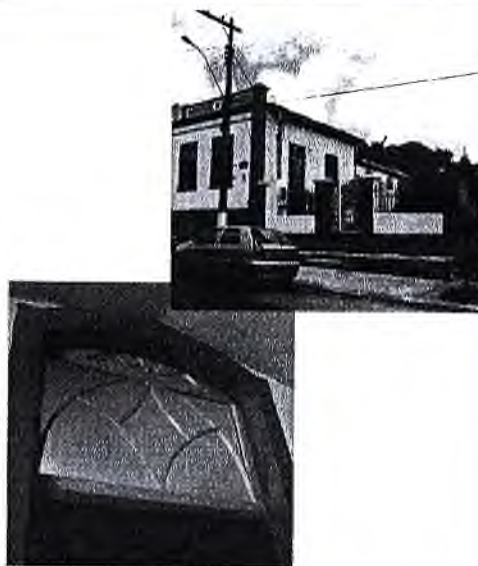
Vista do acesso ao imóvel e detalhe da bandeira interna
