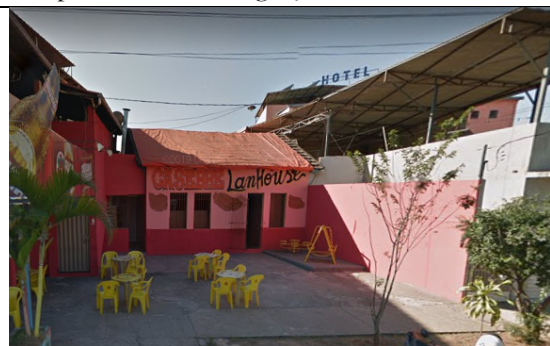
Figura 09 – Imóvel nº 282, com lona sobre cobertura e pintura em tons fortes.
