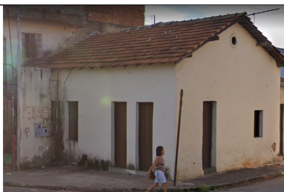
Imagem do imóvel na esquina da rua Londrina com Florianópolis, após as obras de resgate das características originais. Data da imagem: maio de 2019.
