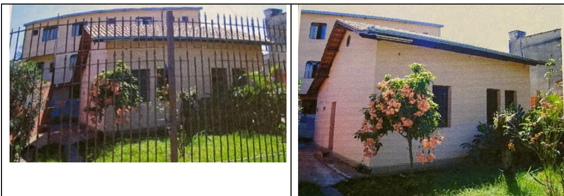
Figuras 06 e 07 : Imagens do imóvel nº 270, constantes do Laudo de estado de conservação de 2007.
