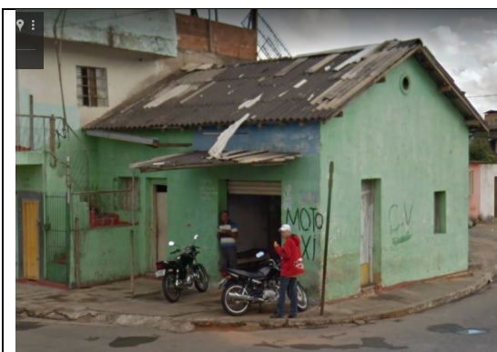
Figura 14 – Imagem do imóvel na esquina da rua Londrina com Florianópolis, situado no perímetro de entorno de tombamento das Casa dos Ferroviários, no ano de 2011.
