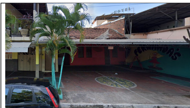
Figura 11 – Cobertura defronte o imóvel de nº 282, prejudicando a sua visibilidade e ambiência.
