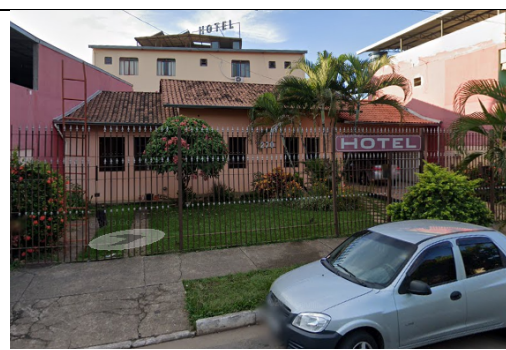
Figura 12 – Novo volume na lateral esquerda do imóvel de nº 270.
