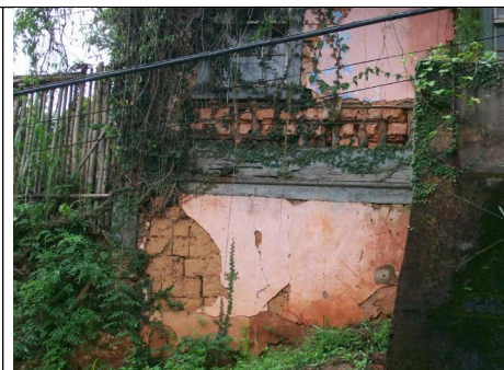
Figura 03 – Alvenaria de terra aparente.
