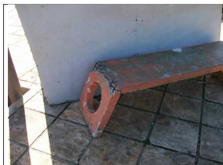
Figura 09 – Banco em mau estado de conservação.
