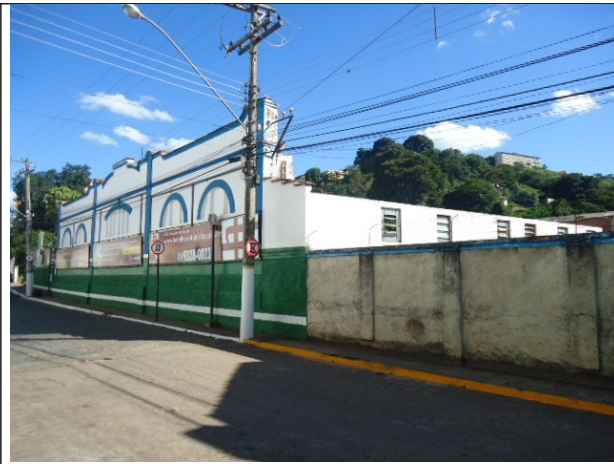
Figura 14 – Local onde se pretende construir o empreendimento, já cercado por tapumes, estando preservada a fachada frontal e parte da lateral.
