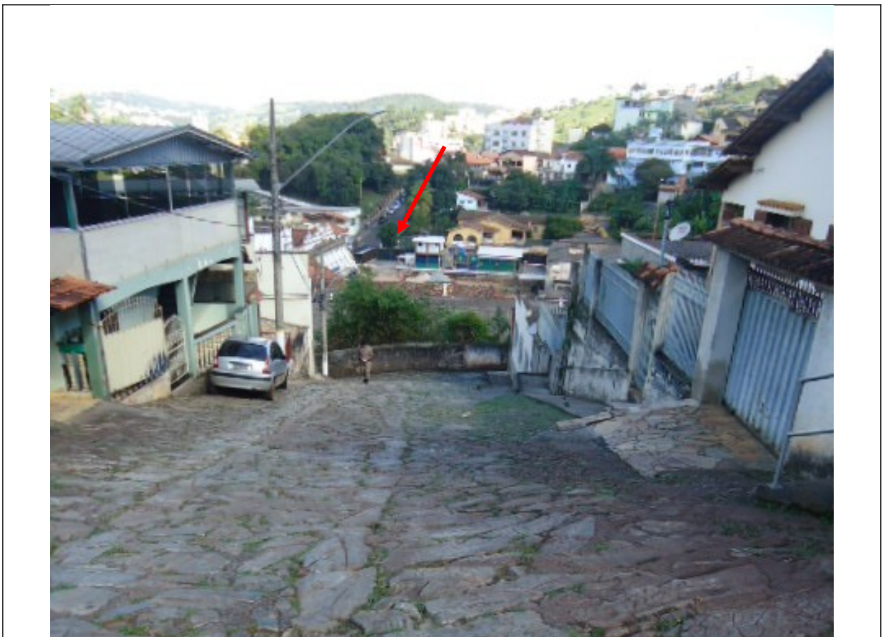
Figura 11 – Vista a partir da Rua do Rosário. Em destaque a localização do empreendimento.
