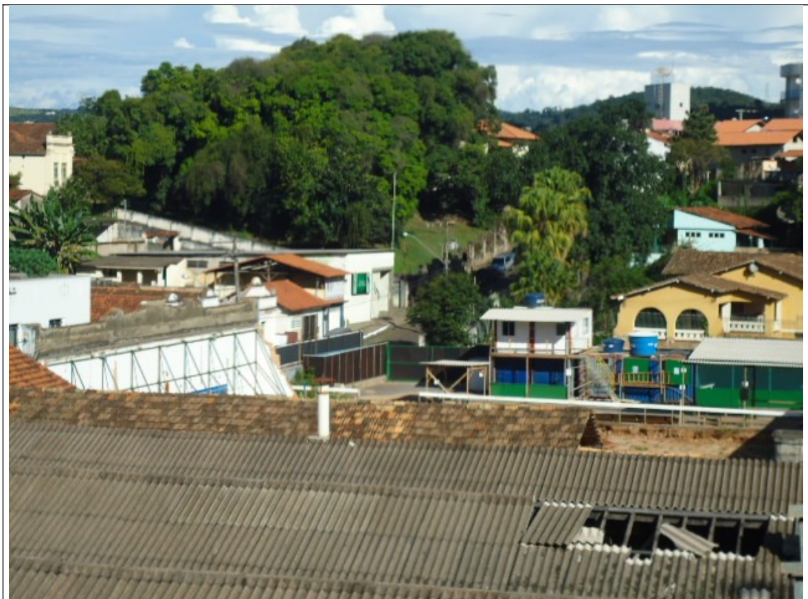
Figura 16 – Vista geral do canteiro de obras onde se pode perceber o terreno fechado por tapumes, a fachada frontal escorada e, em primeiro plano, as outras edificações ainda preservadas da antiga fábrica.
