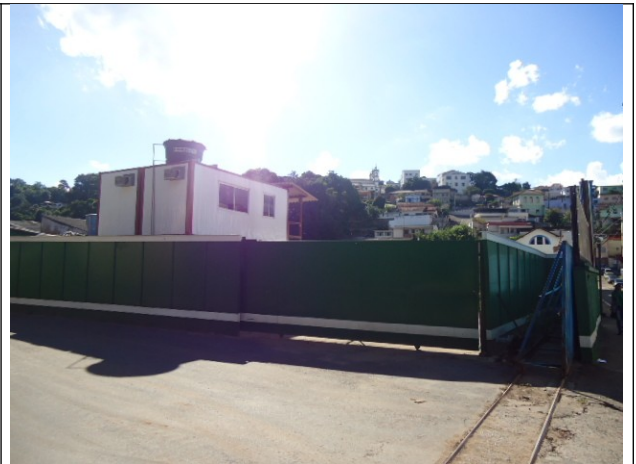
Figura 15 – Tapumes cercando o terreno. Verifica-se que a fachada lateral esquerda e os trechos dos fundos foram totalmente demolidos.
