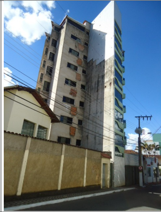
Figura 13 – Prédio de 9 pavimentos na rua Carlos Mitchel nº 55.
