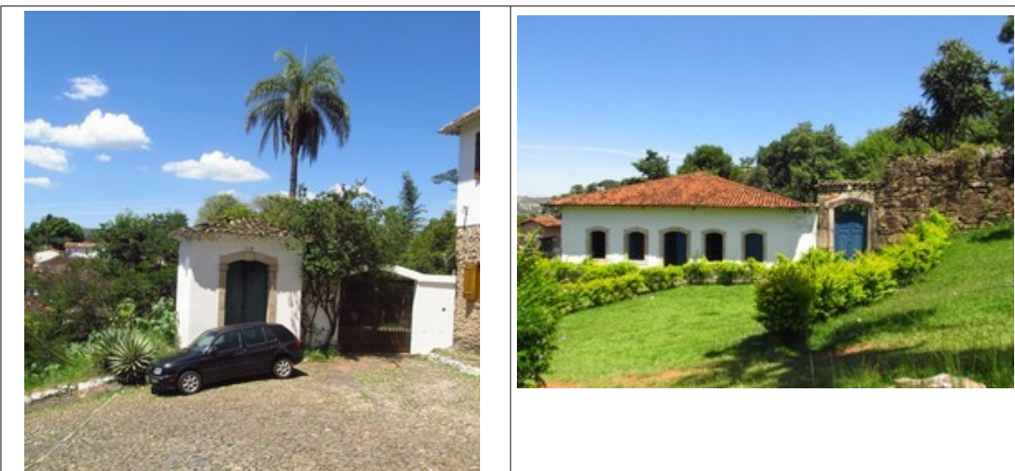
Figuras 14 e 15- Capela do Passo e sede do Coral dos Canarinhos de Itabirito, localizados na Rua Matozinhos. Fotos da vistoria.
