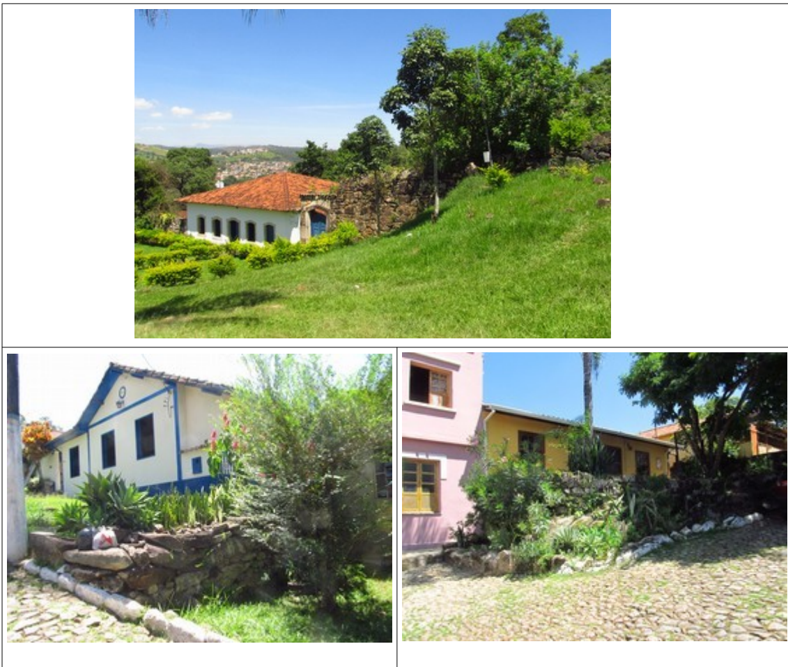
Figuras 48, 49 e 50- Trecho de muro de pedra nas proximidades da sede do Coral dos Canarinhos e de imóveis residenciais da Rua Matozinhos.
