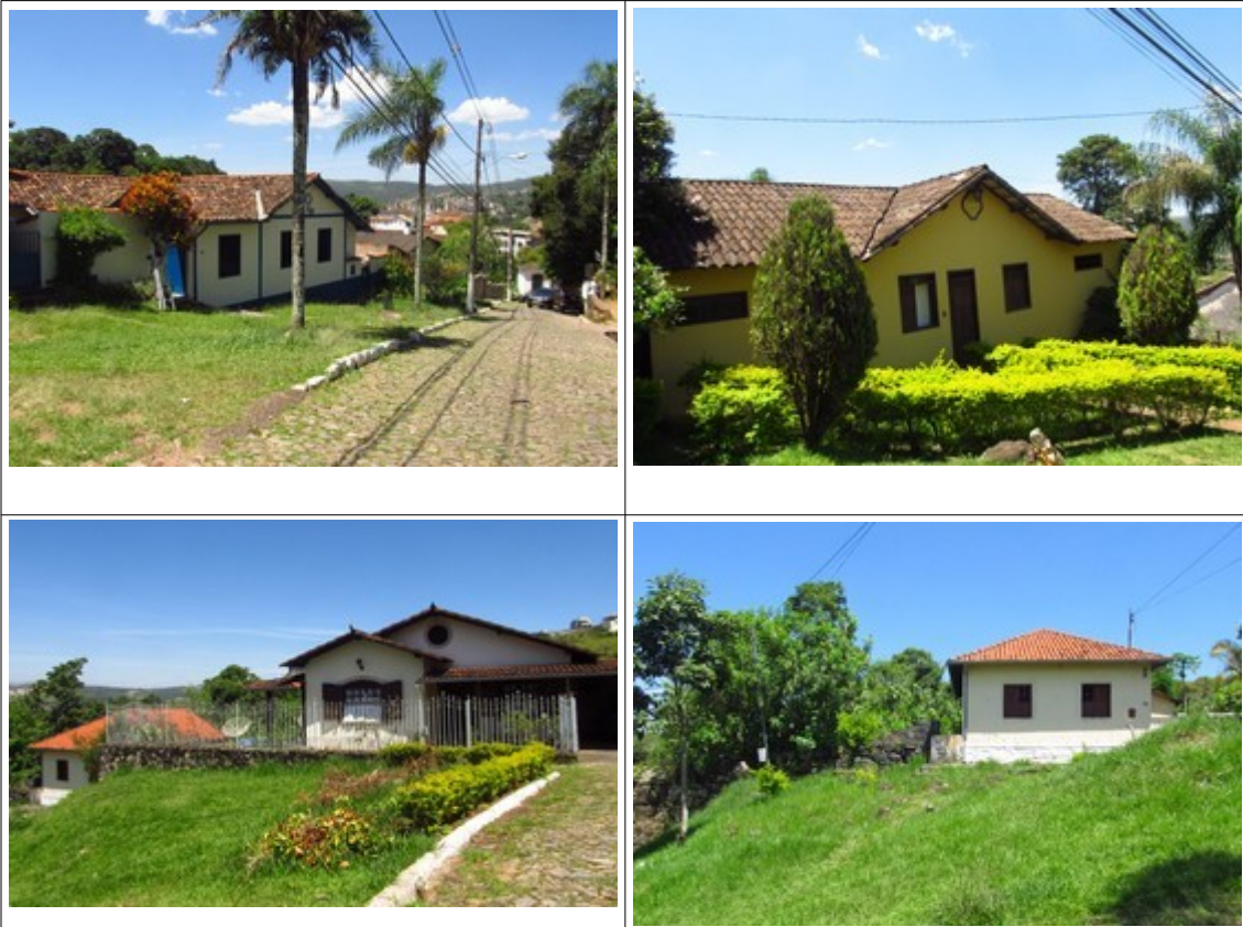
Figuras 10, 11, 12 e 13- Edificações térreas integrantes do conjunto da Rua Matozinhos. Fotos da vistoria.
