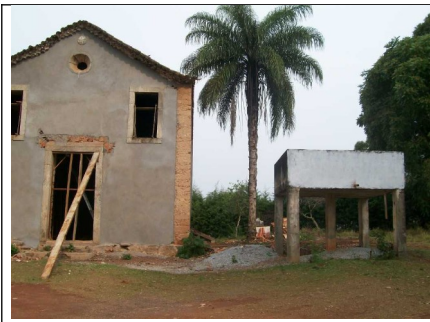
Figura 07 – Caixa d'água no entorno imediato.
