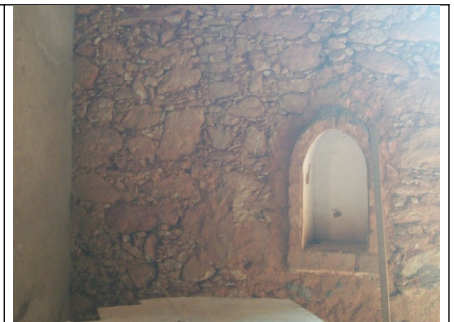
Figura 09 – Alvenaria de pedras e nicho.
