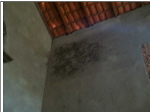
Figuras 10 e 11 – Manchas de umidade.
