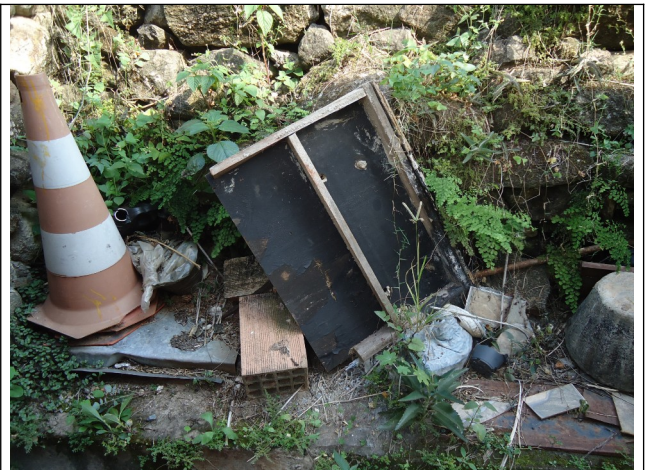
Figura 10 – Entulho e sujeira junto à canaleta de drenagem. Foto da vistoria de maio de 2013.
