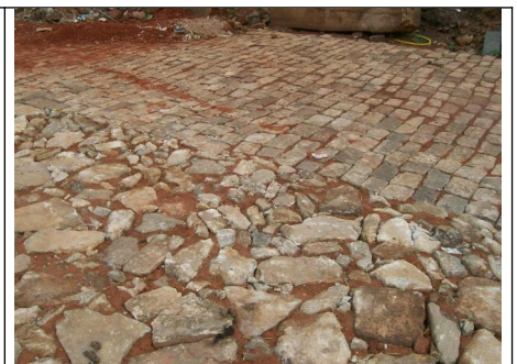
Figura 12 – Utilização de pedras do muro para pavimentação da área interna.
