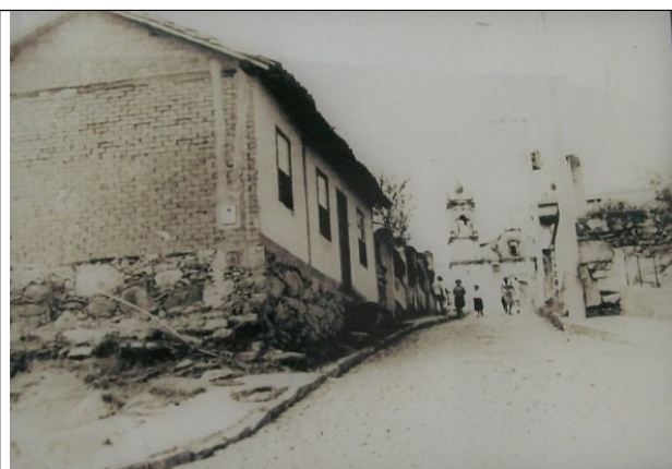
Figura 04 – Vista da rua onde se localiza o muro em 1968.
