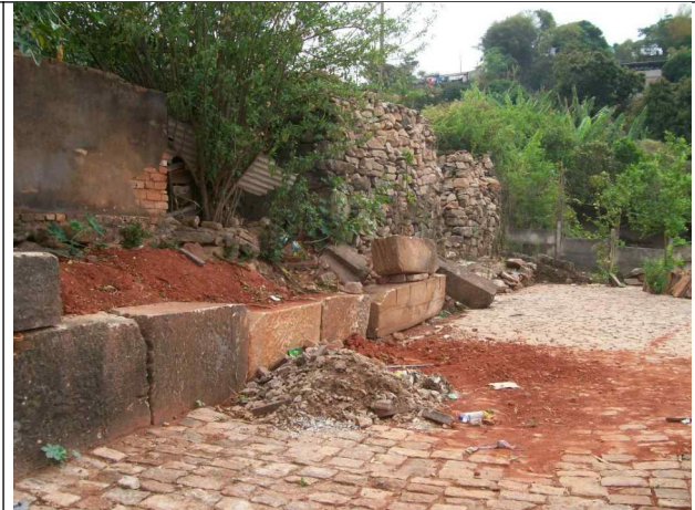
Figura 09 – Construção de muro na lateral.
