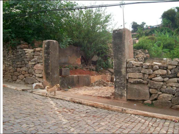
Figura 06 – Trecho demolido do muro.
