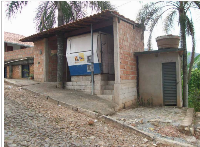
Figura 02 – Intervenção descaracterizante no entorno da capela. Imagens de setembro de 2010.
