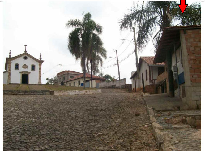
Figura 03 – Intervenção à esquerda e capela ao fundo. Imagens de setembro de 2010.
