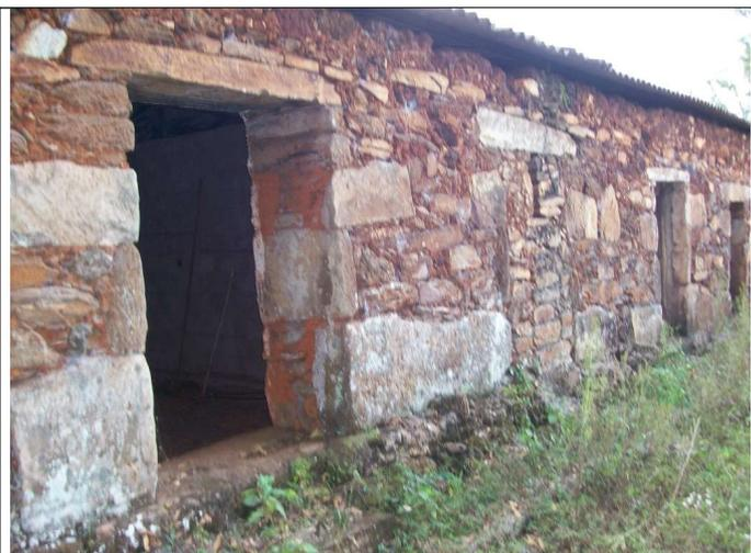
Figura 15 – Vista dos vãos e da alvenaria de pedras.
