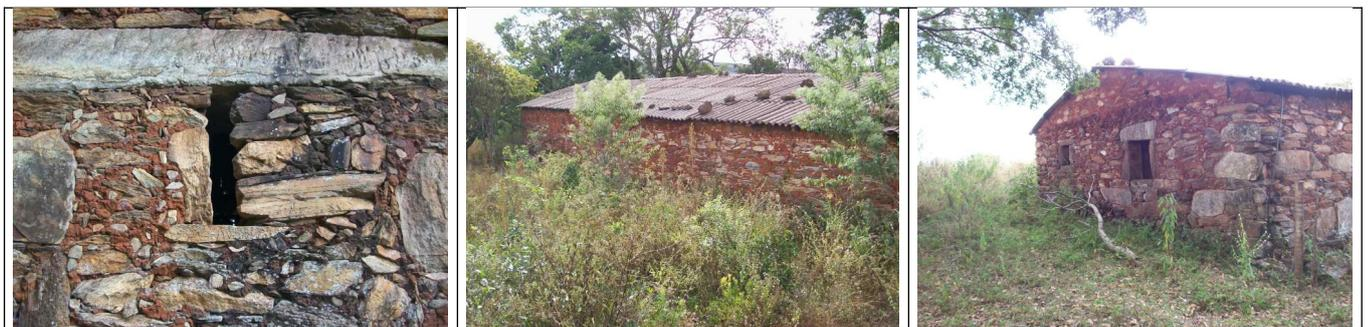
Figuras 18, 19 e 20 – Vista das emendas na alvenaria de pedras.
