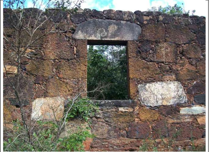
Figura 09 – Paredes em pedra, com assentamento tipo “canjicado”.
