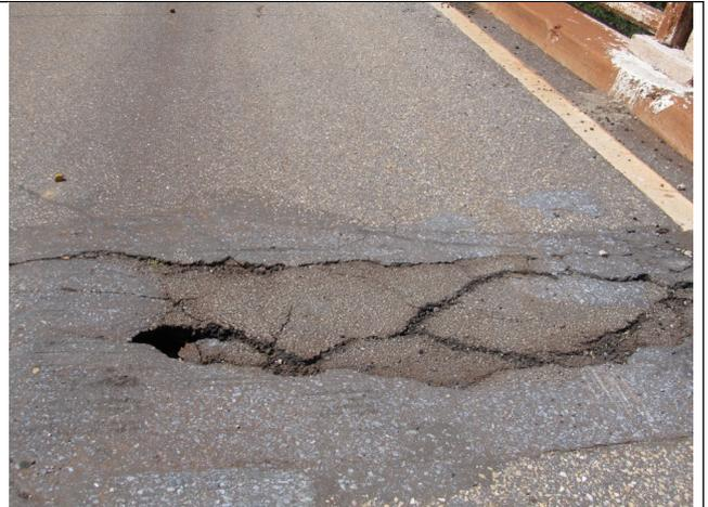
Figura 21 – Danos e desnivelamento no asfalto.
