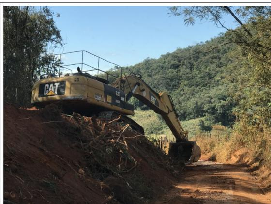
Figura 06 - Máquina realizando o alargamento da estrada de terra.
