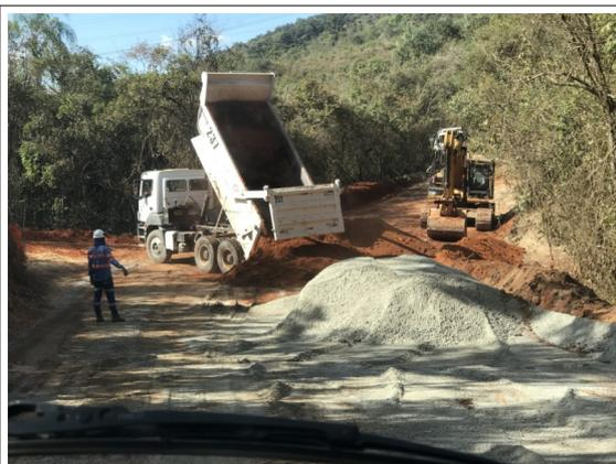
Figura 07 - Caminhão transportando terra e brita para as obras de alargamento da via.
