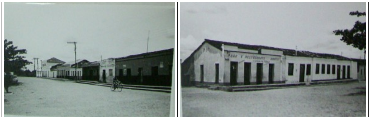
Figuras 12 e 13- Bens inventariados pelo IEPHA na Praça São João, no distrito de São João das Missões.
