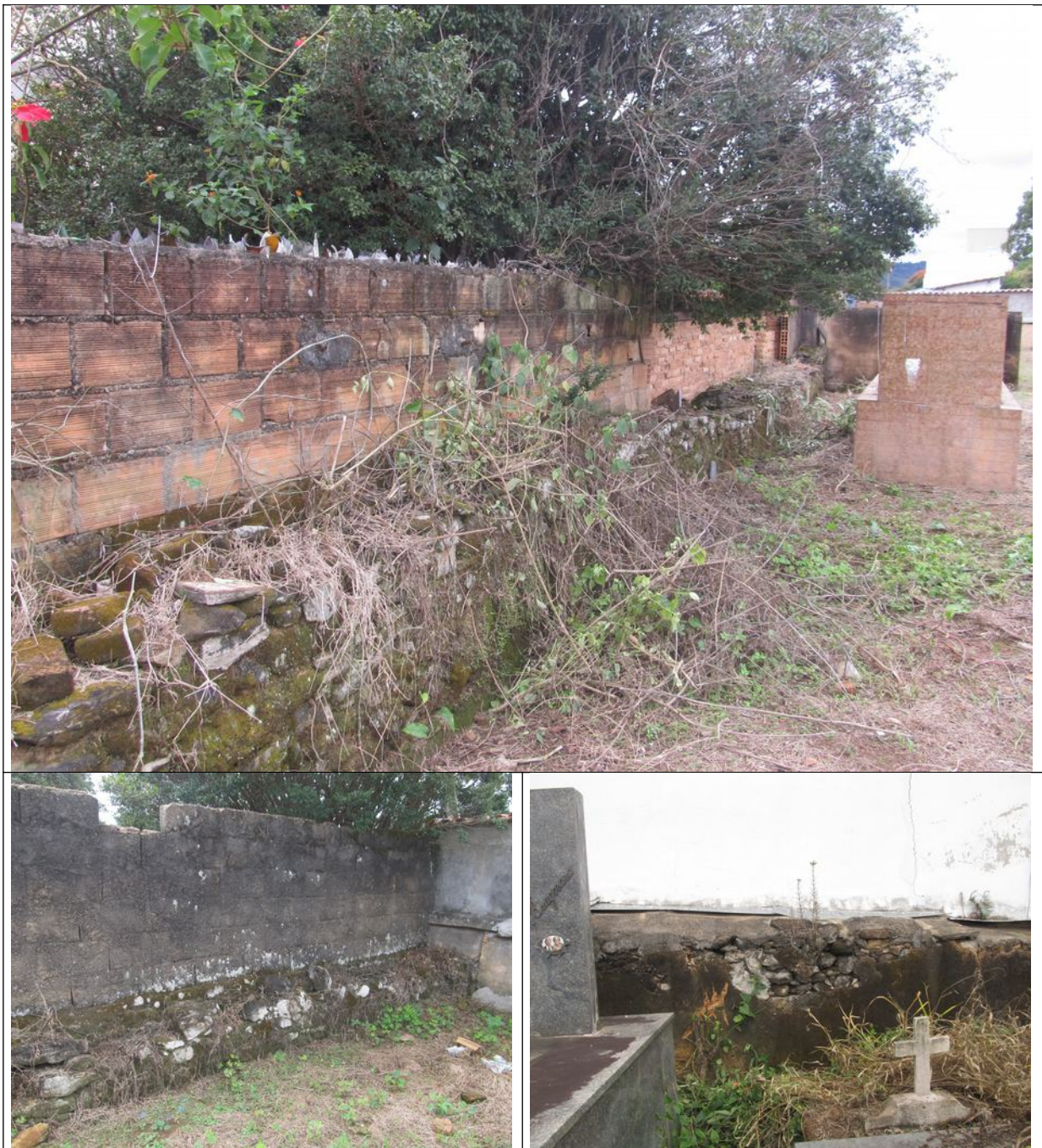
Figuras 41, 42, 43, 44, 45 e 46- Muro de pedras existente no antigo Cemitério de Itaguara.
