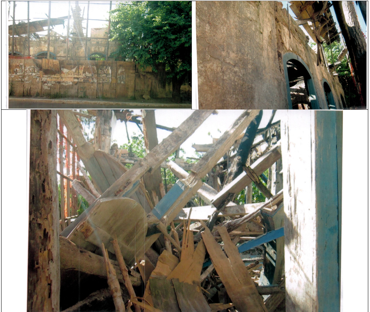
Figuras 02 a 04 – Trechos remanescentes das alvenarias e elementos de madeira que se encontravam dispostos no terreno no ano de 2014.
