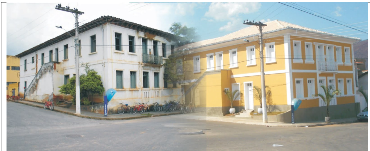
Figura 2 – Montagem contendo dois momentos de um mesmo prédio, à esquerda verifica-se o sobrado do antigo Fórum em processo de deterioração, à direita o prédio restaurado para uso da Secretaria de Cultura, Casa de Cultura, Biblioteca Municipal e Museu Histórico Frei Agostinho.
