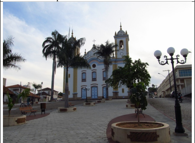
Figura 9 – Igreja Matriz de Itapecerica. Fonte: Fotografia da vistoria realizada pelo Setor Técnico desta Promotoria ao Núcleo Histórico de Itapecerica.
