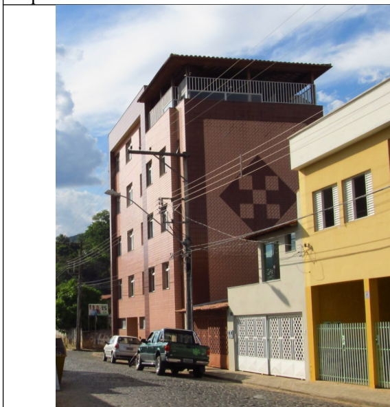
Figura 38 – Prédio na Rua Lamounier Godofredo, nº 300. Fonte: Fotografia da vistoria realizada pelo Setor Técnico desta Promotoria ao Núcleo Histórico de Itapecerica
