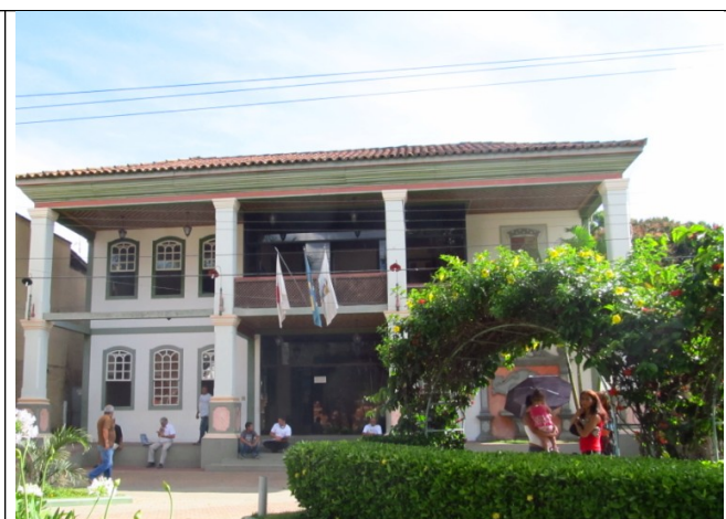
Figura 23 – Prefeitura Municipal de Itapecerica, construída no local onde ficava o Grupo Escolar da cidade. Fonte: Fotografia da vistoria realizada pelo Setor Técnico desta Promotoria ao Núcleo Histórico de Itapecerica.
