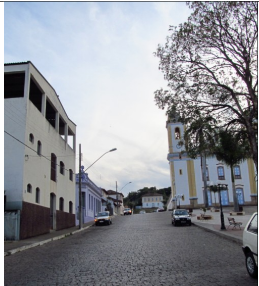
Figura 35 – Prédio na Praça São Bento. Fonte: Fotografia da vistoria realizada pelo Setor Técnico desta Promotoria ao Núcleo Histórico de Itapecerica
