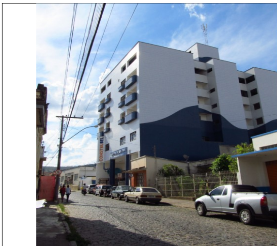
Figura 36 – Prédio na Rua Vigário Antunes, nº 392. Fonte: Fotografia da vistoria realizada pelo Setor Técnico desta Promotoria ao Núcleo Histórico de Itapecerica
