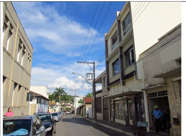
Figura 34 – Prédio na Rua Vigário Antunes, nº 267. Fonte: Fotografia da vistoria realizada pelo Setor Técnico desta Promotoria ao Núcleo Histórico de Itapecerica
