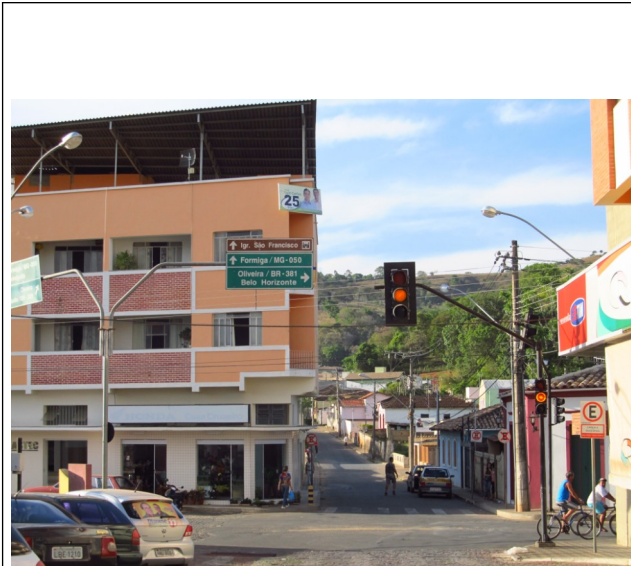
Figura 40 – Prédio na Praça da Rodoviária. Fonte: Fotografia da vistoria realizada pelo Setor Técnico desta Promotoria ao Núcleo Histórico de Itapecerica
