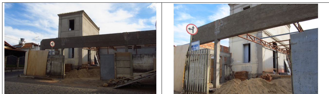
Figuras 13 e 14 – Obras nos fundos do imóvel da Rua Coronel Leopoldo, nº 154. Fonte: Fotos da vistoria realizada em 16/10/2012.
