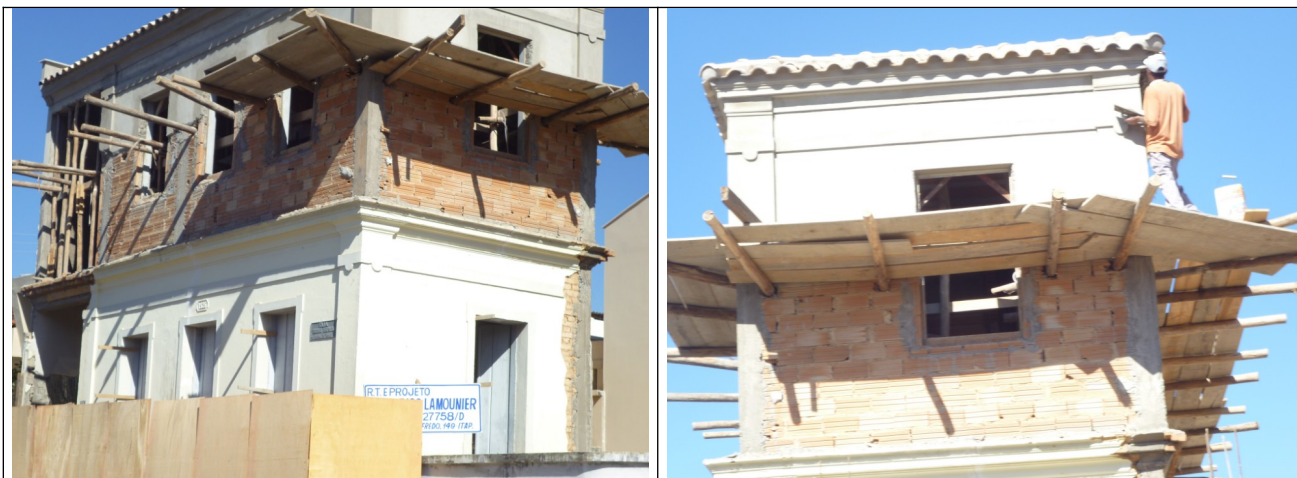
Figuras 08 e 09 – Fotografias da obra de alteração do imóvel. Fonte: CD juntado aos autos.
