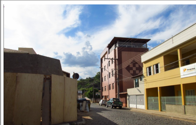
Figura 15– Prédio localizado na Rua Lamounier Godofredo, próximo ao imóvel objeto deste laudo. Fonte: Fotos da vistoria realizada em 16/10/2012.
