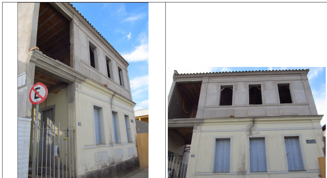
Figuras 11 e 12 – Construção do segundo pavimento no imóvel da Rua Coronel Leopoldo, nº 154. Fonte: Fotos da vistoria realizada em 16/10/2012.
