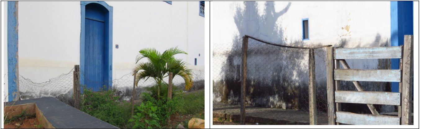
Figuras 24 e 25- Cerca de arame farpado nas laterais da Igreja de São Francisco. Fonte: Foto da vistoria de 16/10/2012
