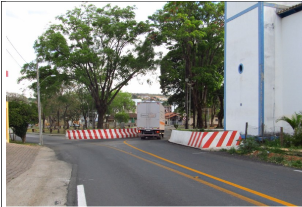
Figura 21- Caminhão transitando entre os muros construídos no Largo de São Francisco. Fonte: Foto da vistoria de 16/10/2012
