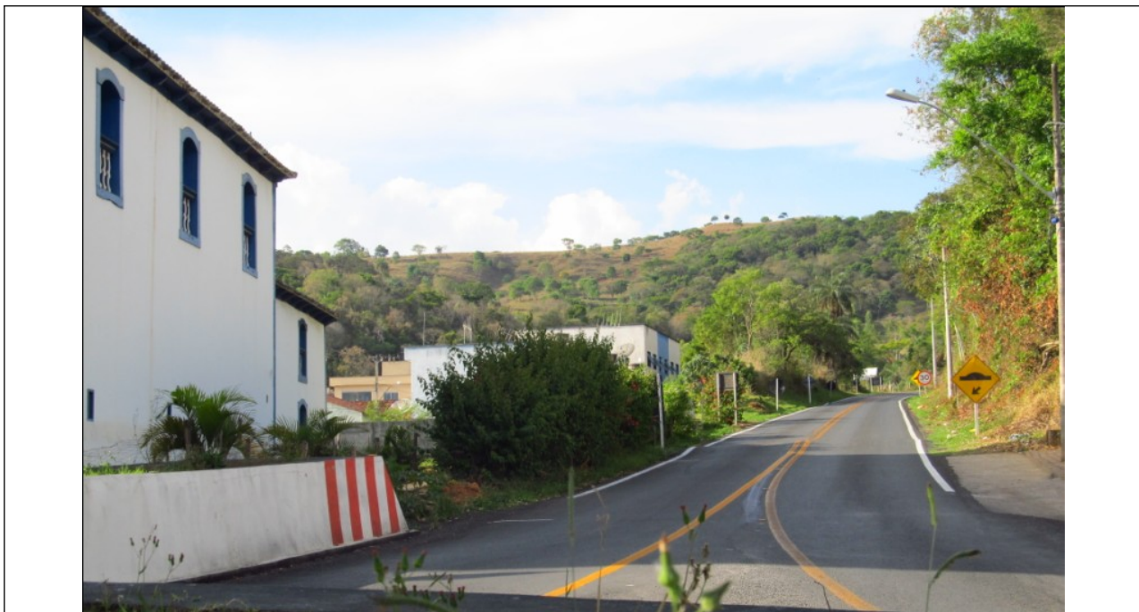
Figura 23- Placas indicando quebra-molas e limite de velocidade na rodovia que passa ao lado da Igreja de São Francisco. Fonte: Foto da vistoria de 16/10/2012
