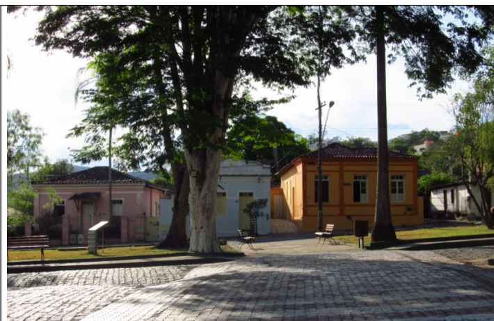
Figura 15- Residências situadas no Largo de São Francisco. Fonte: Foto da vistoria de 16/10/2012.
