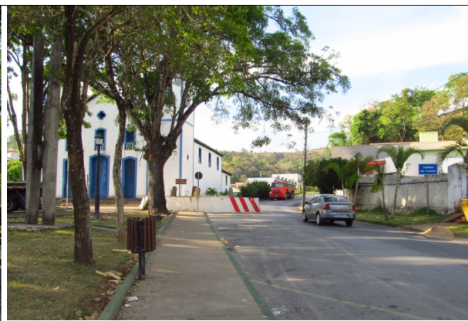
Figura 16- Lateral direita da Igreja de São Francisco, destacando a rodovia e o cemitério. Fonte: Foto da vistoria de 16/10/2012.
