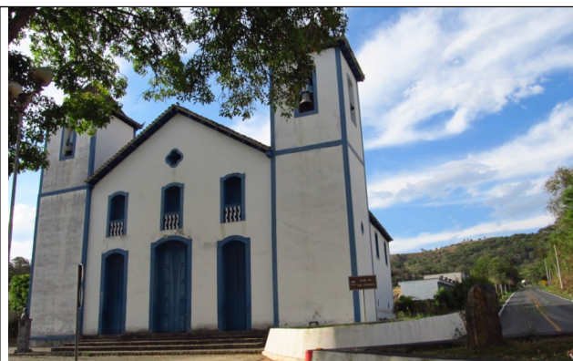
Figura 17- Rodovia passando ao lado da Igreja de São Francisco. Fonte: Foto da vistoria de 16/10/2012.
