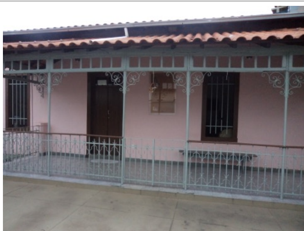
Figura 42 – Entrada de acesso ao interior da edificação. Fonte: Registro realizado por este setor técnico durante vistoria.
