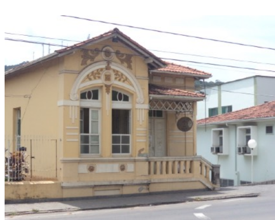
Figura 15 – Acima edificação construída ao lado da antiga casa de Misericórdia. Verificou-se que está em bom estado de conservação. Seu uso atual é o de ser banco de leite para as mães.
