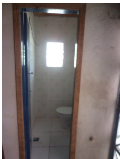
Figura 51 – Fotografia de um dos banheiros existentes no cômodo.
