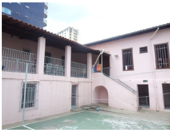
Figura 44 – Parte externa posterior da construção, quintal. Fonte: Registro realizado por este setor técnico durante vistoria.
