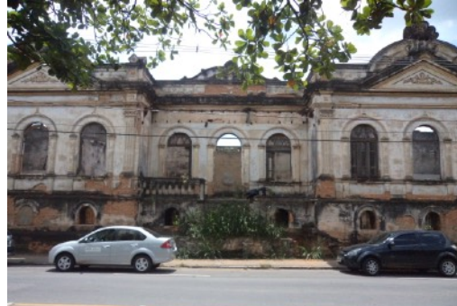
Figura 13 – Aspecto atual da construção. Verificou-se que ela está em péssimo estado de conservação.
