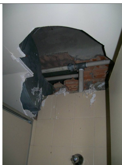
Figuras 15 a 17 – Infiltrações e vazamentos.
