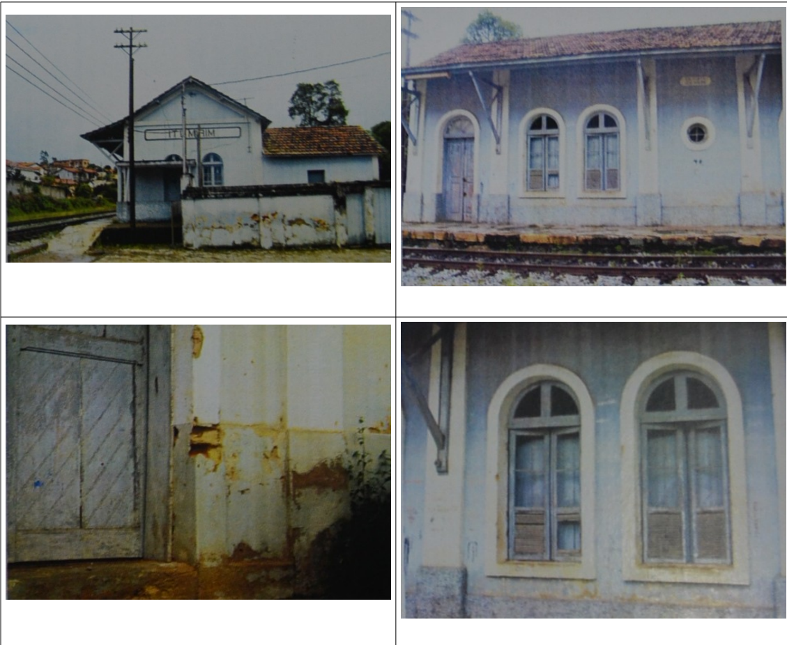
Figura 12, 13, 14 e 15- Imagens da Estação Ferroviária de Itumirim constantes no último laudo do estado de conservação enviado ao IEPHA.
