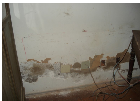
Figura 10- Detalhe de parede interior da Estação Ferroviária.
